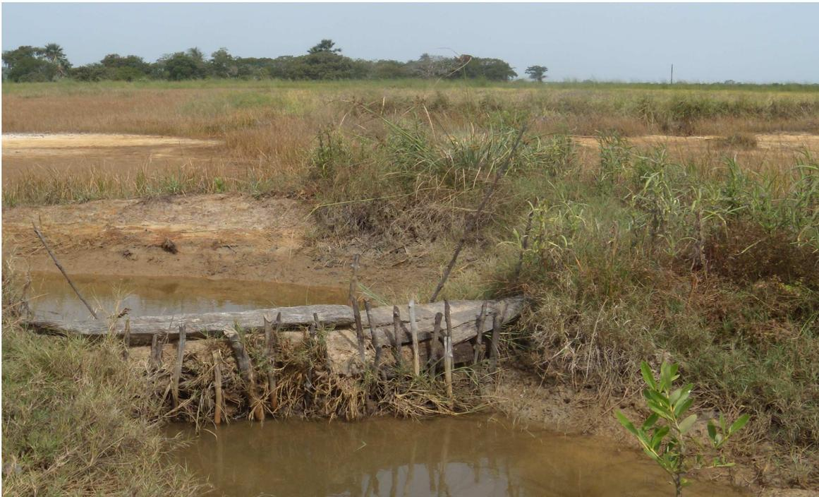
Figura 3.8. Dique que serve para impedir a entrada da água salgada nas *bolanhas*. (Fonte: Fotografia tirada no decorrer do trabalho de campo.)
