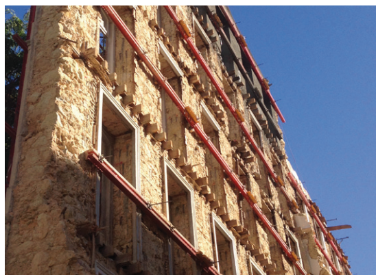
Esquerda Left Romina Sodoma Rúben Carneiro Rui Areias Visita à obra do Santander Totta
