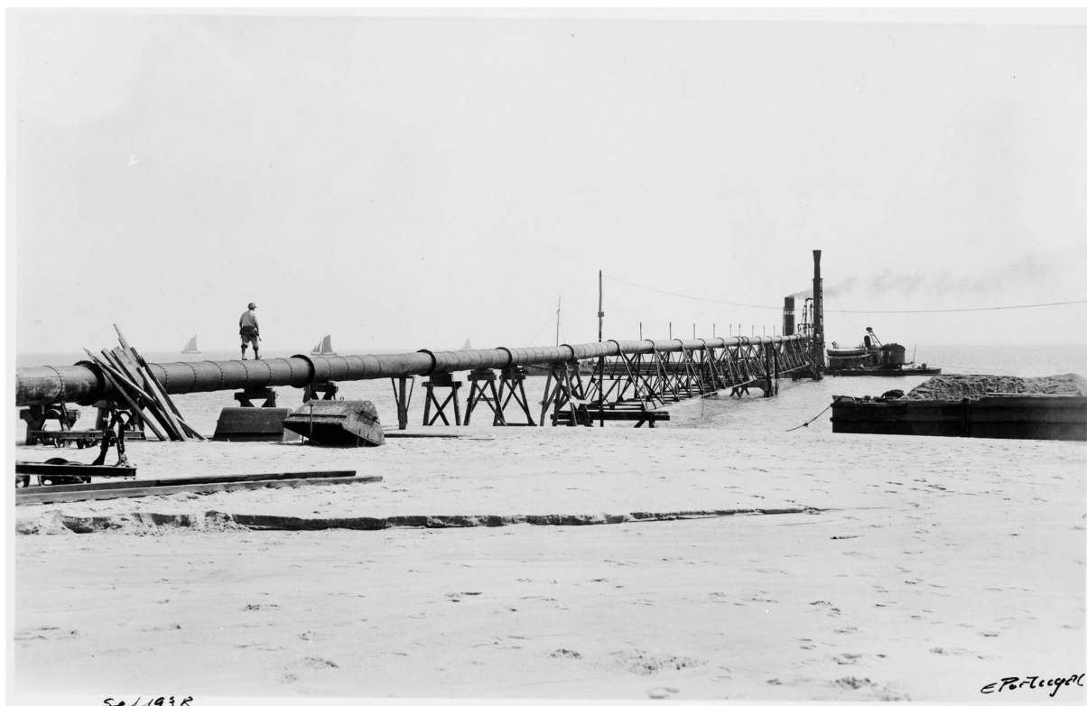
Figura 4.1 – “Obras de construção do aterro, transporte de areia para implantação da Fábrica de Gás da Matinha”.
