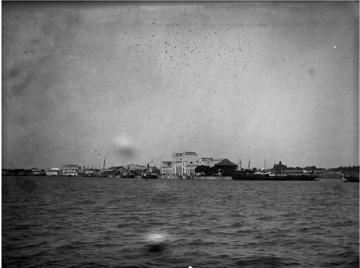
Figura 3.42 – “Estação do Barreiro”.
