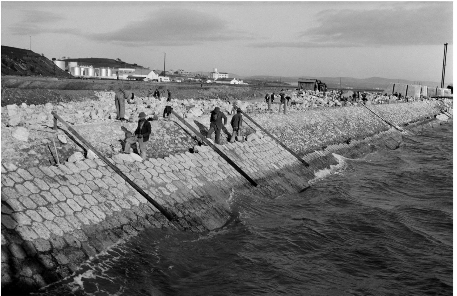
Figura 17. Construção do talude empedrado no aterro da Matinha, 1938, Eduardo Portugal.
