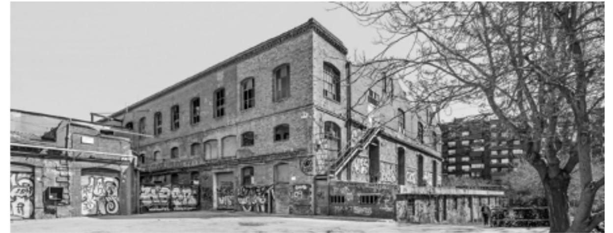
Figura 26 Bloco 7 antes da intervenção.
