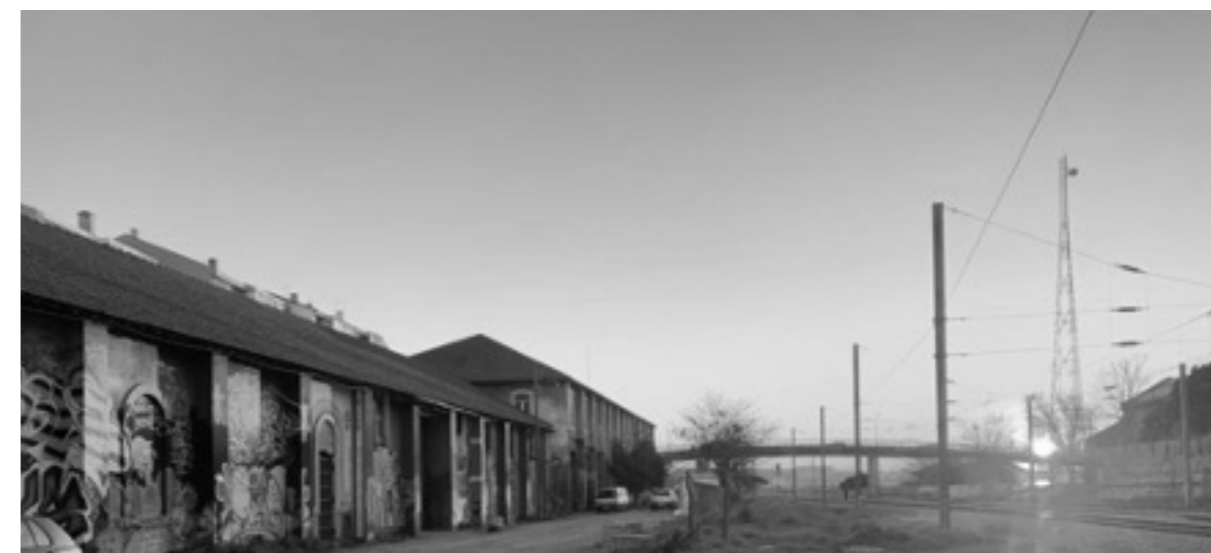
Figura 33 Vista parcial da estrutura ferroviária – edificado e linhas
