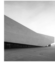
08 Fachada do Edifício (FG+S0)
