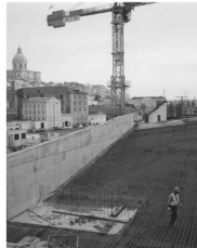
05 Vista aérea da construção do Terminal de Cruzeiros (Autor: João Duarte, s.d.)
