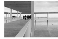
09 Passarela de acesso aos cruzeiros (FG+S0)
