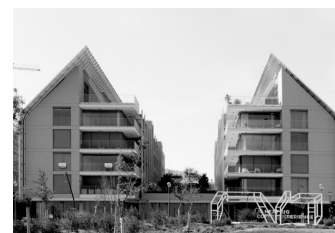
17 Fachada virada a nascente do conjunto habitacional de Braço de Prata. Joana Marques, (2020).
