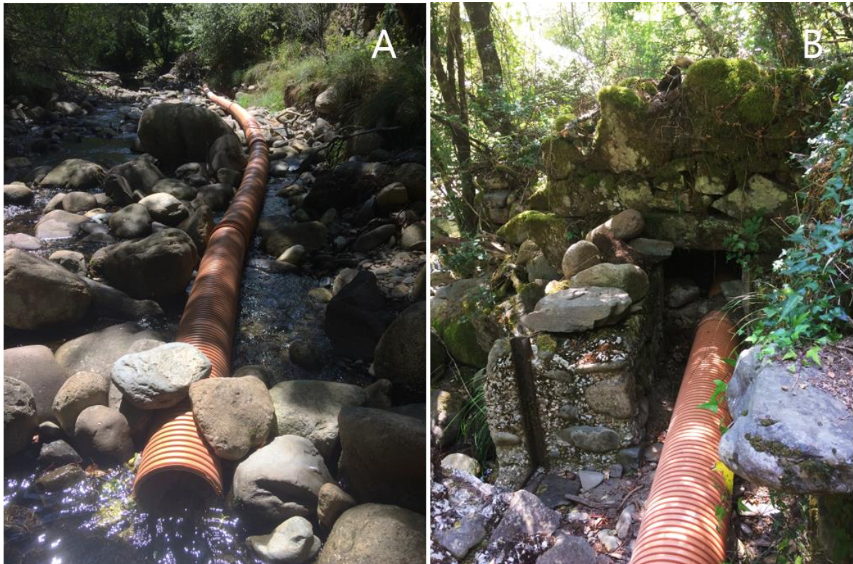
Figura 6 - Levada dos Amaros A) uso dos tubos de plástico no poço dos Amaros, B) entrada na levada construída de pedra e cimento, onde conseguimos identificar a antiga comporta do açude, do lado esquerdo.
