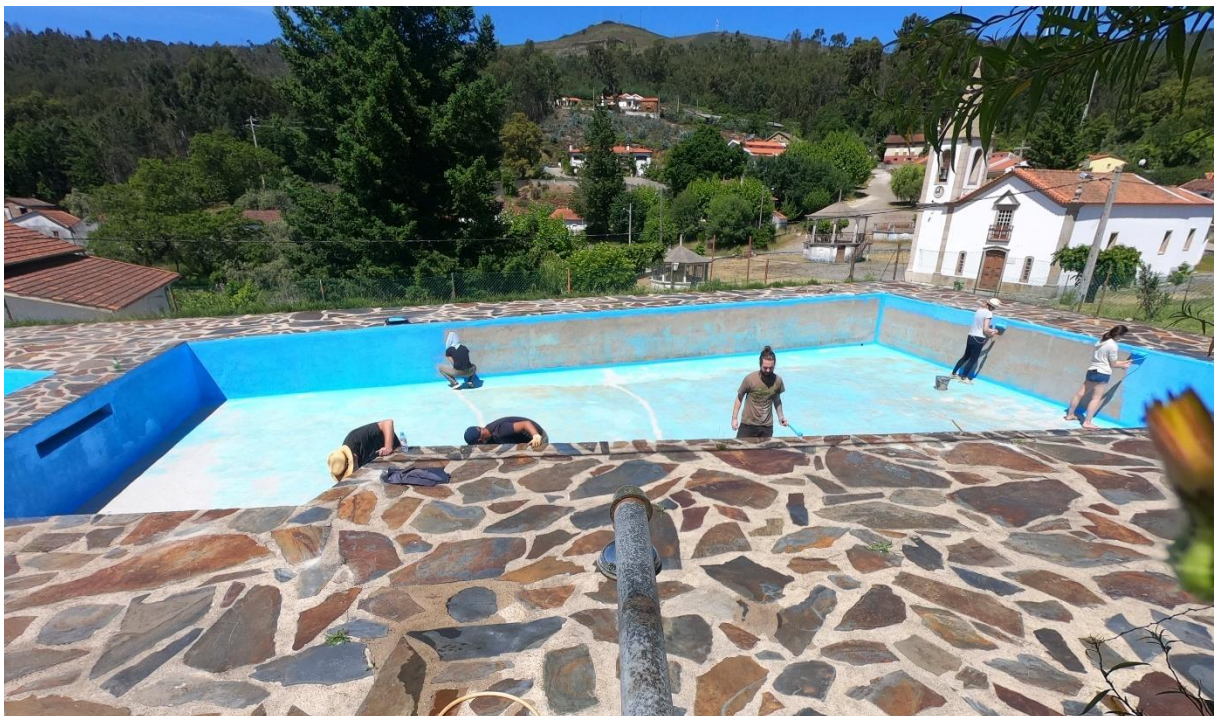
Figura 8 - Recuperação do tanque de Pera.
