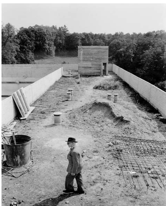
FIG. 76. O telhado do Convento de La Tourette, le Corbusier por Rene Burri
