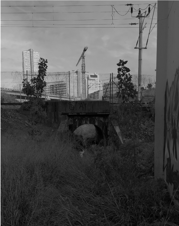
FIG. 59. Túnel sob a linha ferroviária b
