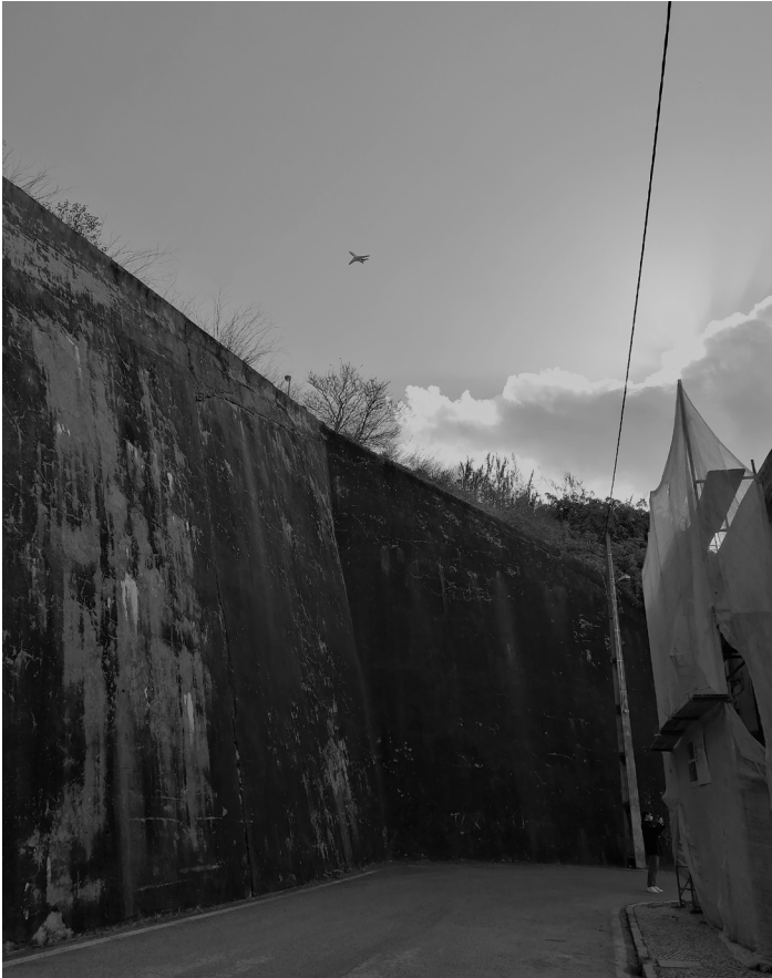
FIG. 61. Muro de contenção de terra na Travessa da Rua Particular nº1
