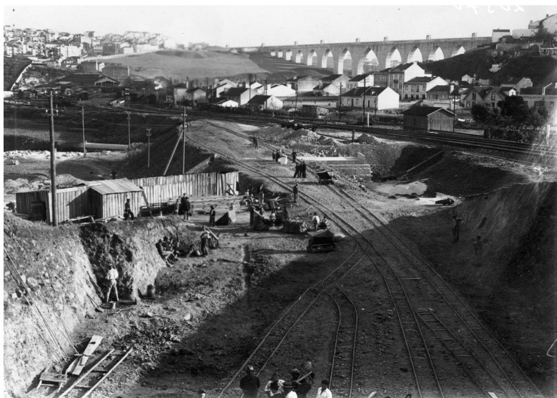
FIG. 22. Construção da linha ferroviária em Campolide
