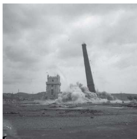
Fig. 096 Demolição das Chaminés Industriais, Belém
