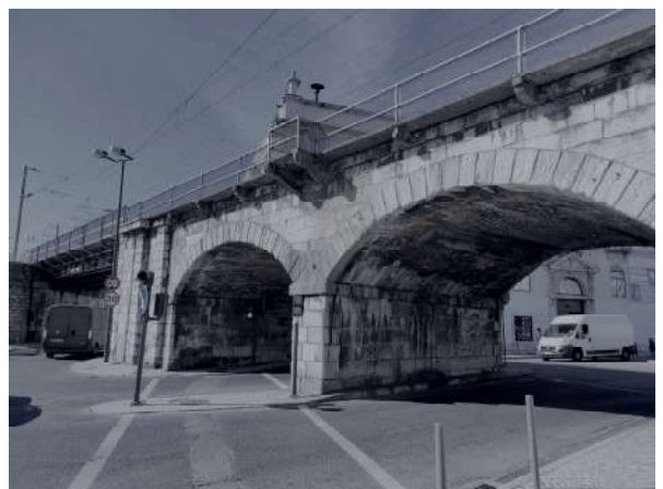
Fig. 011 Viaduto de Xabregas
