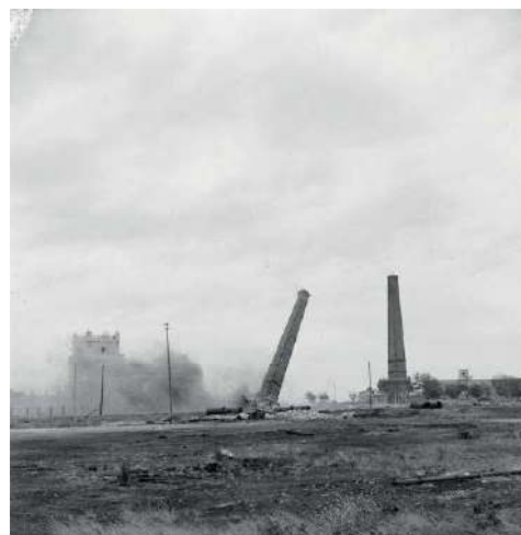
Fig. 095 Demolição das Chaminés Industriais, Belém
