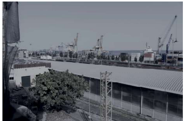
Fig. 010 Instalações CP-Comboios Portugal, Linha Ferroviária Norte
