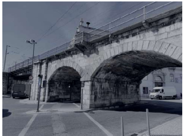
Fig. 078 Viaduto de Xabregas
