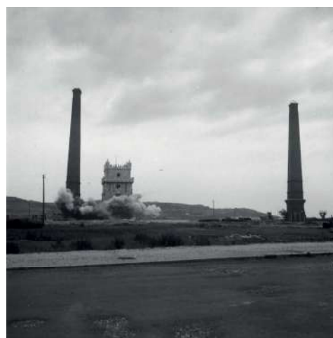
Fig. 097 Demolição das Chaminés Industriais, Belém
