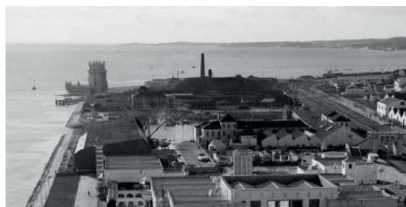
Fig. 021 Vista aérea sobre o núcleo fabril de Belém, Fábrica de Gás
