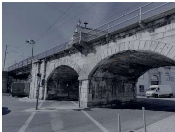
Fig. 037 Viaduto de Xabregas
