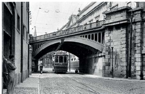
Fig. 022 Viaduto de Xabregas
