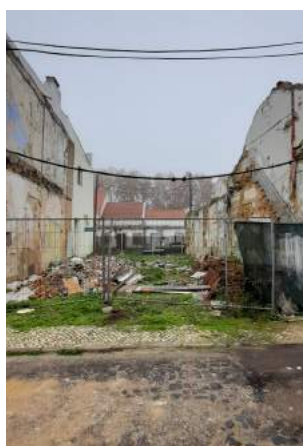
Figura 49: Vazio urbano como ponto de acumulação de lixo
