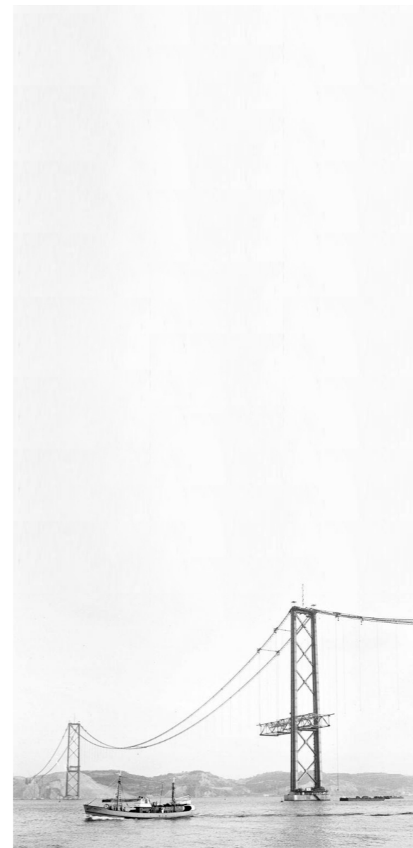
FIGURA 40 - CONTRUÇÃO PONTE 25 DE ABRIL
