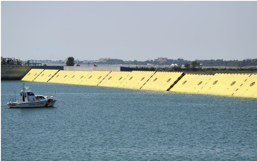
Figura 65. Barreiras móveis amarelas são vistas na superfície da água durante testes do projeto Mose, em Veneza, na Itália, na sexta-feira (10) – Foto: Reuters/Flavio Lo Scalzo, 2020. Fonte: https://g1.globo.com/mundo/noticia/2020/07/10/veneza-testa-com-sucesso-novo-sistema-de-diques.ghtml
