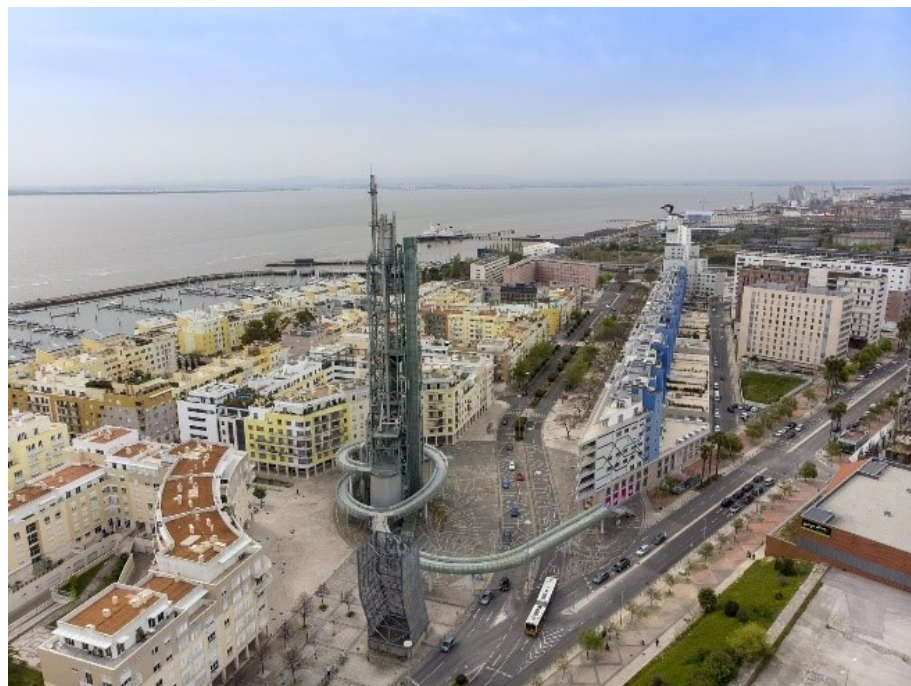
Figura 86. Torre da Sacor no enfiamento visual da alameda dos Oceanos (Wie, Herbert, 2020).
