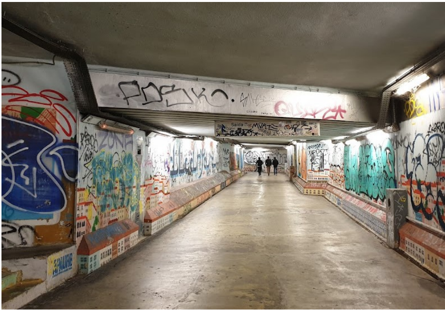
Figura 93. Túnel pedonal de Alcântara-mar, autor desconhecido, s.d. Fonte: https://bussola- pt.com/356156/alcantara- mar
