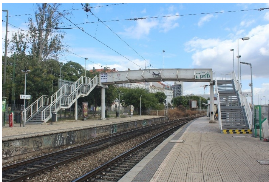
Figura 92. Exemplar de passagem aérea standarizada, existente no Apeadeiro de Santos, (elaborado pelo autor, 2020)
