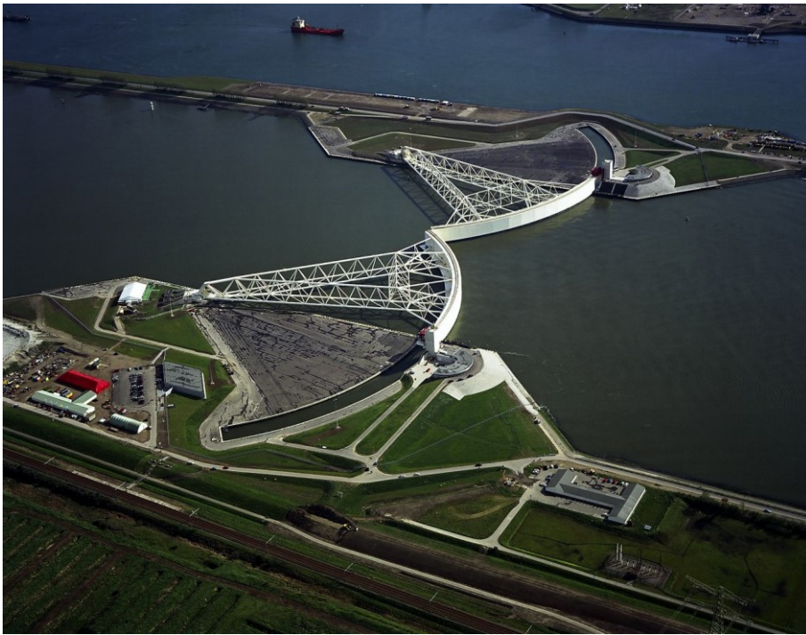
Figura 67. A Barreira Maeslant serve ao propósito complexo de manter Rotterdam a salvo do mar e, ao mesmo tempo, manter seu porto aberto. Delta Cities, 2017, Fonte: https://www.vox.com/energy-and-environment/2017/11/15/16651460/rotterdam-climate-change-sea-level-rise
