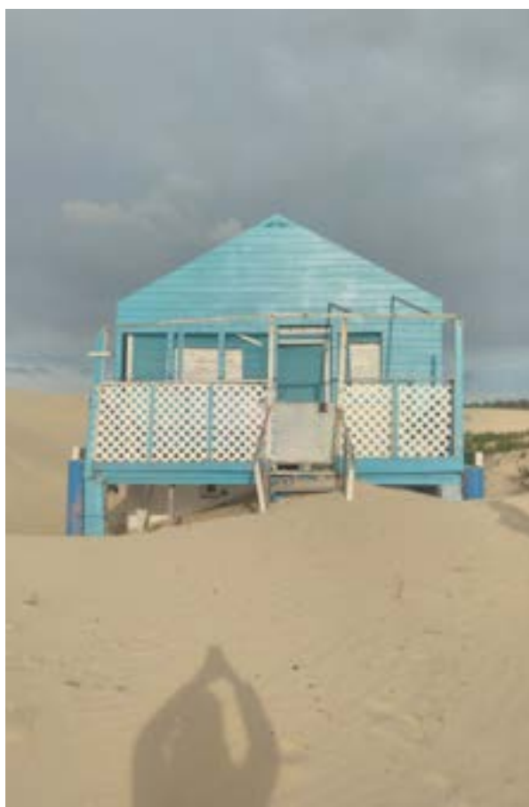
Figura 146 - Cabana de pescadores, recuperada pelos Arquitetos Sem Fronteiras-Portugal - adaptação do sistema construtivo ao movimento das areias (Novembro de 2020)
