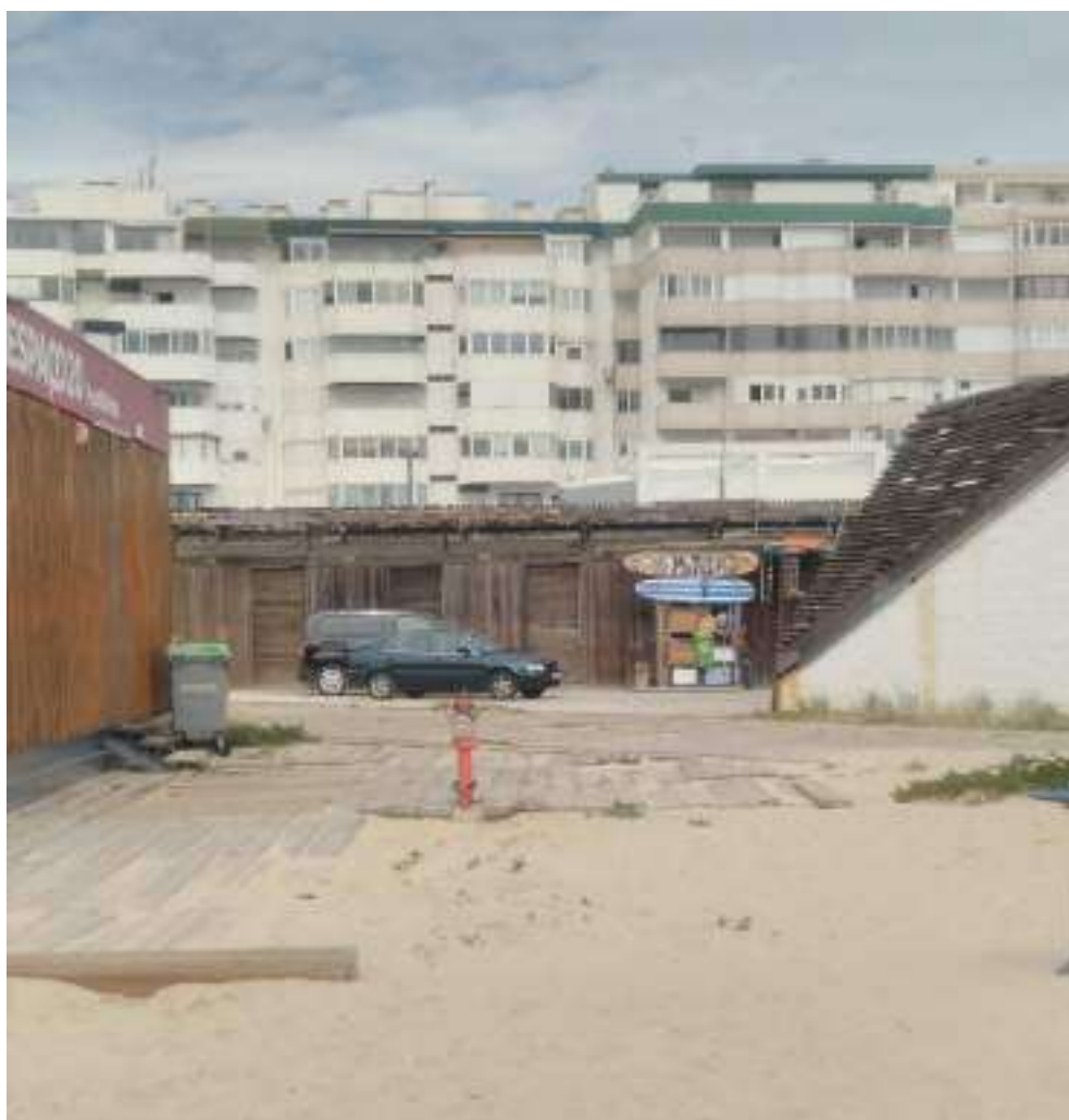
Figura 211 - O conjunto de abrigos, para o armazenamento dos apetrechos de pesca, construídos no âmbito do programa Polis - destaque o contraste entre as “massas” dos prédios de habitação e a aparência, frágil e degradada, dos abrigos, e em relação às madeiras do apoio de praia à esquerda - apesar de mais baixos, são estes edifícios que destoam na envolvente urbana (Novembro de 2020)
