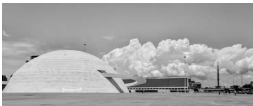
Figura 193 - Oscar Niemeyer e Lúcio Costa, Museu Nacional de Brasília (ou Honestino de Guimarães), Brasília (2006 - fotografia de Gonzalo Viramonte), vista exterior da estrutura da cobertura semi-circular, que funciona à semelhança de uma “pele” protetora do interior
