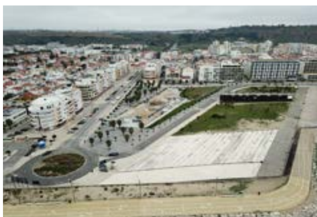
Figura 60 - Atual área da Polícia Marítima, e do Posto de Socorros, após a intervenção do programa Polis
