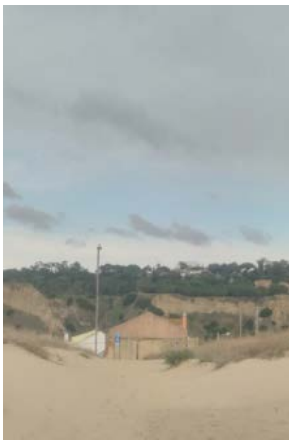
Figura 155 - Cabana de pescadores, recuperada pelos Arquitetos Sem Fronteiras-Portugal - simbiose da arquitetura com a paisagem das dunas e da arriba (Novembro de 2020)
