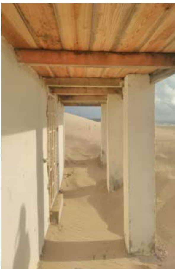
Figura 144 - Cabana de pescadores, recuperada pelos Arquitetos Sem Fronteiras-Portugal - sistema de fundações sobreelevado da duna (pormenor - Novembro de 2020)
