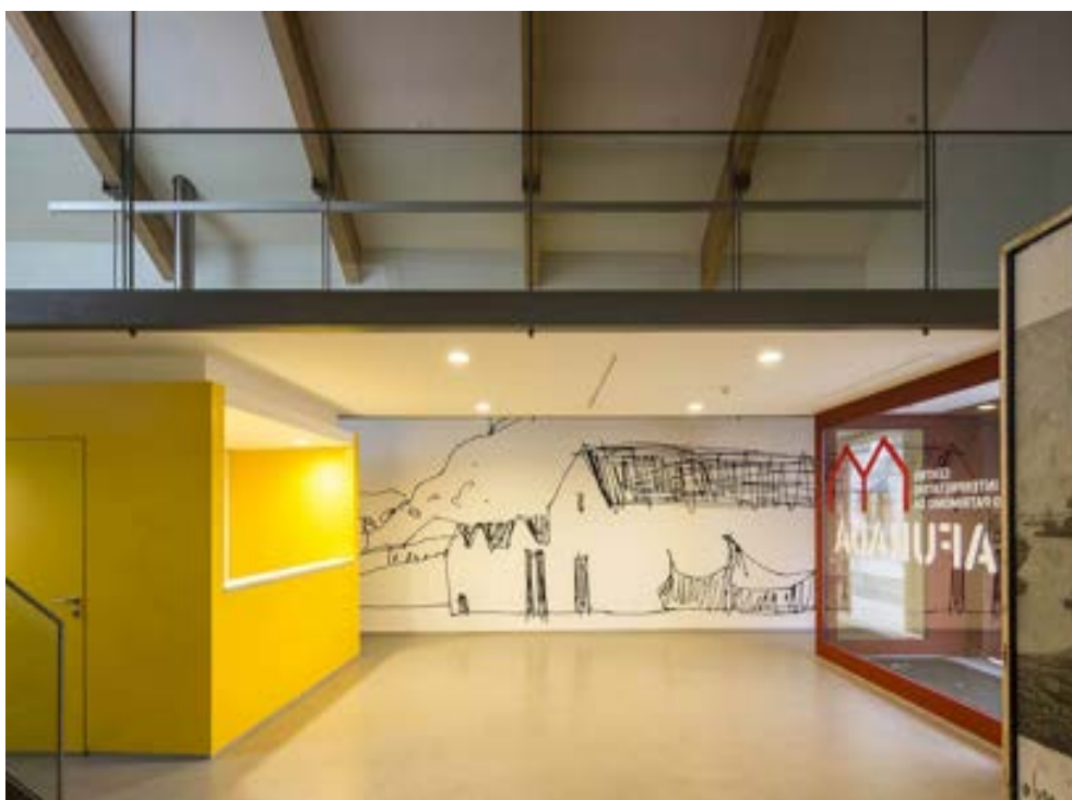
Figura 198 - Atelier 15, Centro Interpretativo do Património da Afurada, Vila Nova de Gaia (2014) - vista da entrada principal do espaço museológico, com destaque para a área de pé-direito duplo do foyer e para o mezanino
