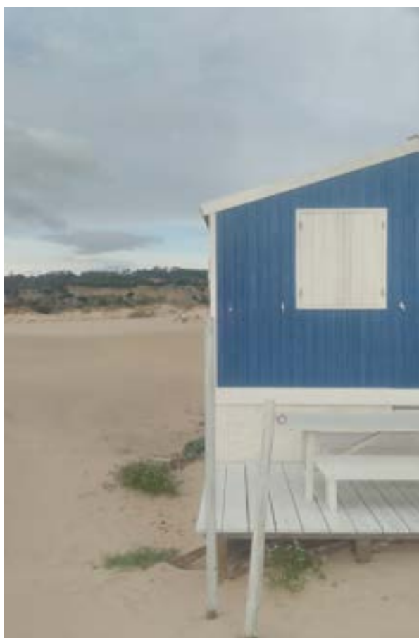
Figura 149 - Cabana de pescadores, recuperada pelos Arquitetos Sem Fronteiras-Portugal - pormenor do sistema de fundação, em estacaria de madeira (Novembro de 2020)
