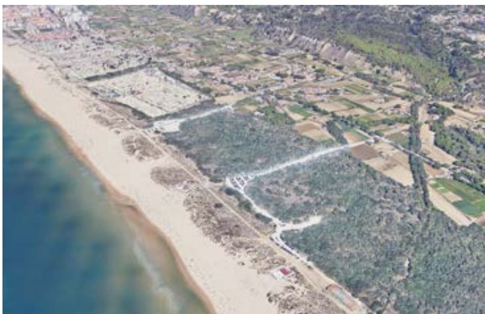
Figura 65 - Estacionamento atuais para automóveis, nas matas
