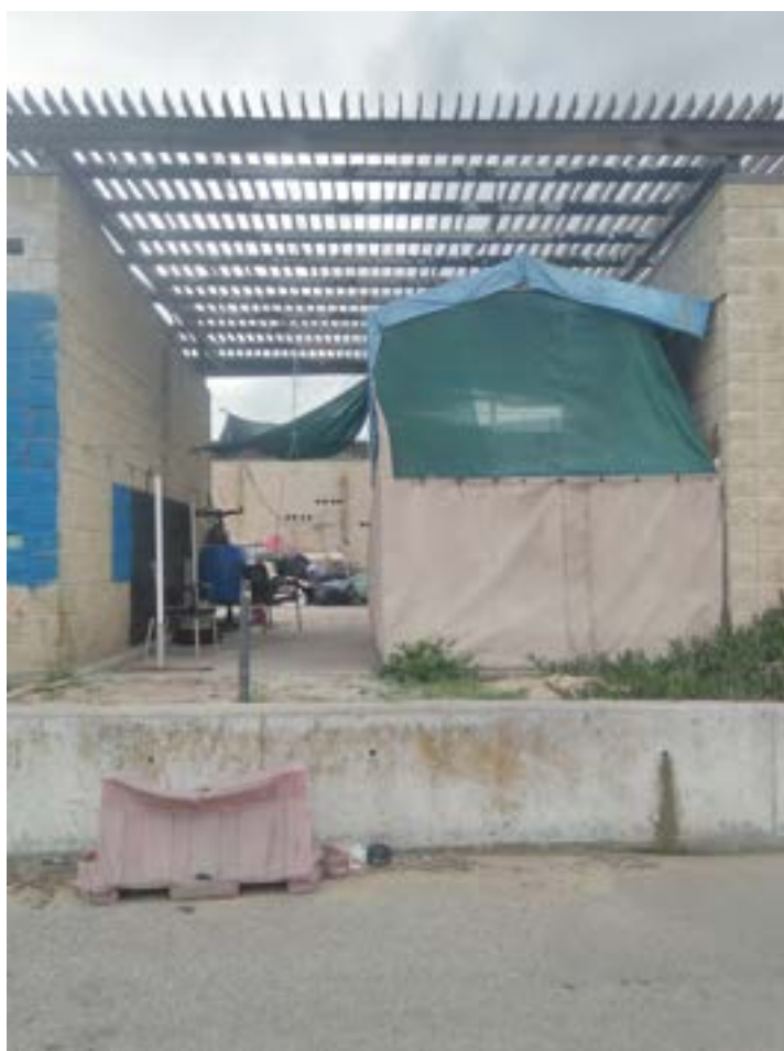
Figura 53 - Ocupação informal junto aos abrigos de pescadores, construídos no âmbito do Programa Polis
