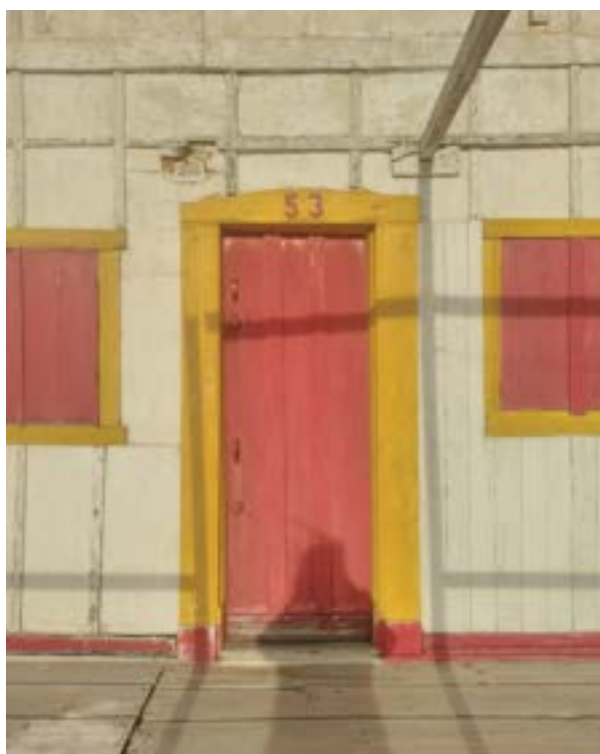
Figura 44 - Cabana de pescadores recuperada pelos Arquitetos Sem Fronteiras - Portugal (pormenor)
