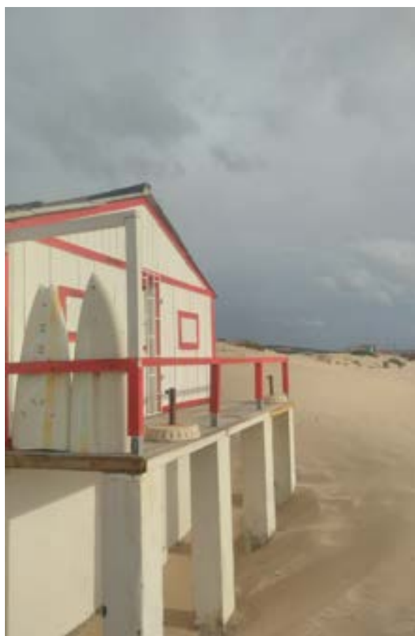
Figura 143 - Cabana de pescadores, recuperada pelos Arquitetos Sem Fronteiras-Portugal - sistema de fundações sobreelevado da duna (Novembro de 2020)
