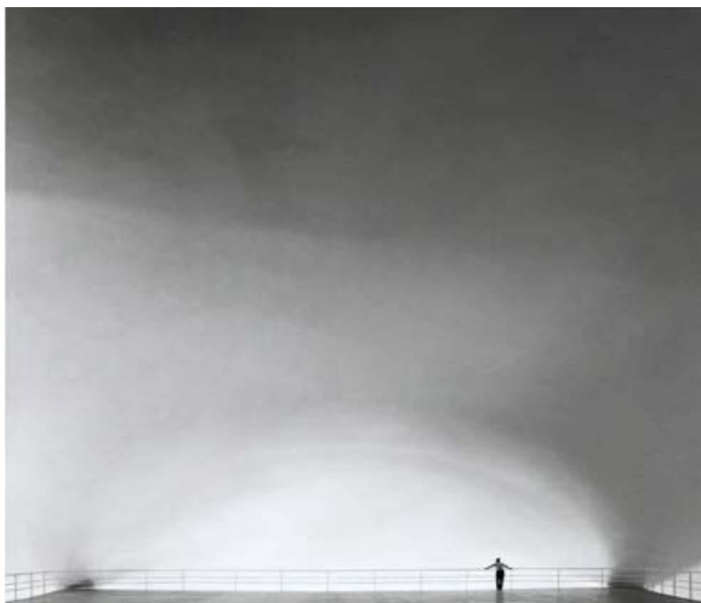
Figura 192 - Oscar Niemeyer, OCA - Pavilhão Lucas Nogueira Garcez, Parque do Ibirapuera, São Paulo (1954) - pormenor da articulação entre as lajes, dos vários pisos, e a cobertura abobadada, com destaque para a modelação particular dos interiores, em função de uma luz focada e da textura do betão
