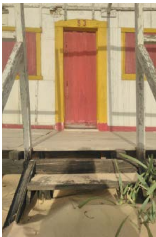
Figura 147 - Cabana de pescadores, recuperada pelos Arquitetos Sem Fronteiras-Portugal - adaptação do sistema construtivo ao movimento das areias (Novembro de 2020)
