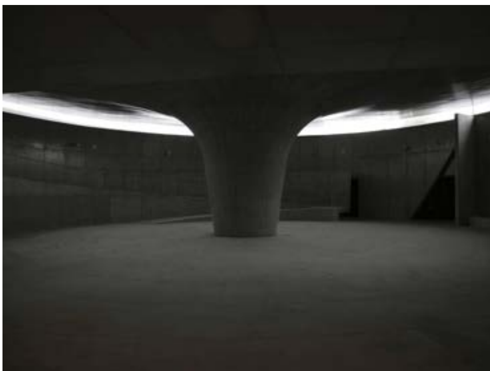
Figura 180 - Nuno Ribeiro Lopes, Centro de Interpretação do Vulcão dos Capelinhos, Horta, Açores (2006-2008) - pormenor do espaço circular do foyer, com destaque para a modelação das superfícies através da entrada de luz zenital, e para o betão
