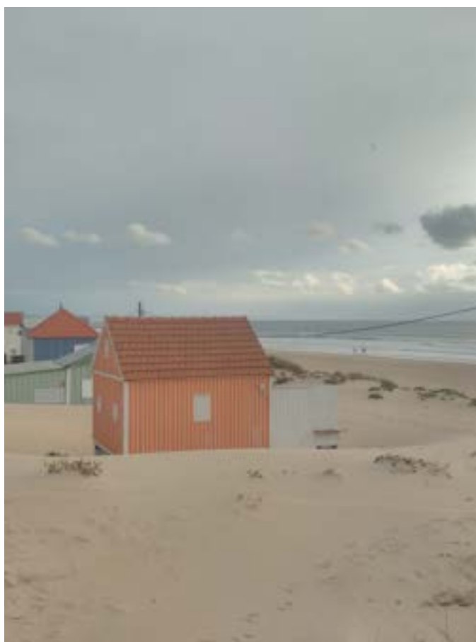
Figura 84 - Cabanas de pescadores, recuperadas pelos Arquitetos Sem Fronteiras-Portugal (Dezembro de 2020)
