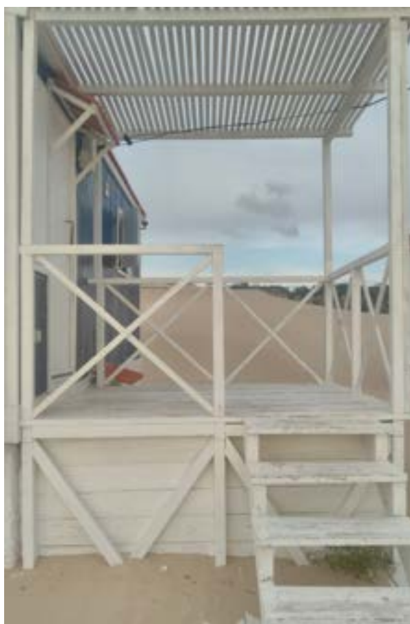
Figura 150 - Cabana de pescadores, recuperada pelos Arquitetos Sem Fronteiras-Portugal - relação de flexibilidade entre a duna e a edificação (Novembro de 2020)
