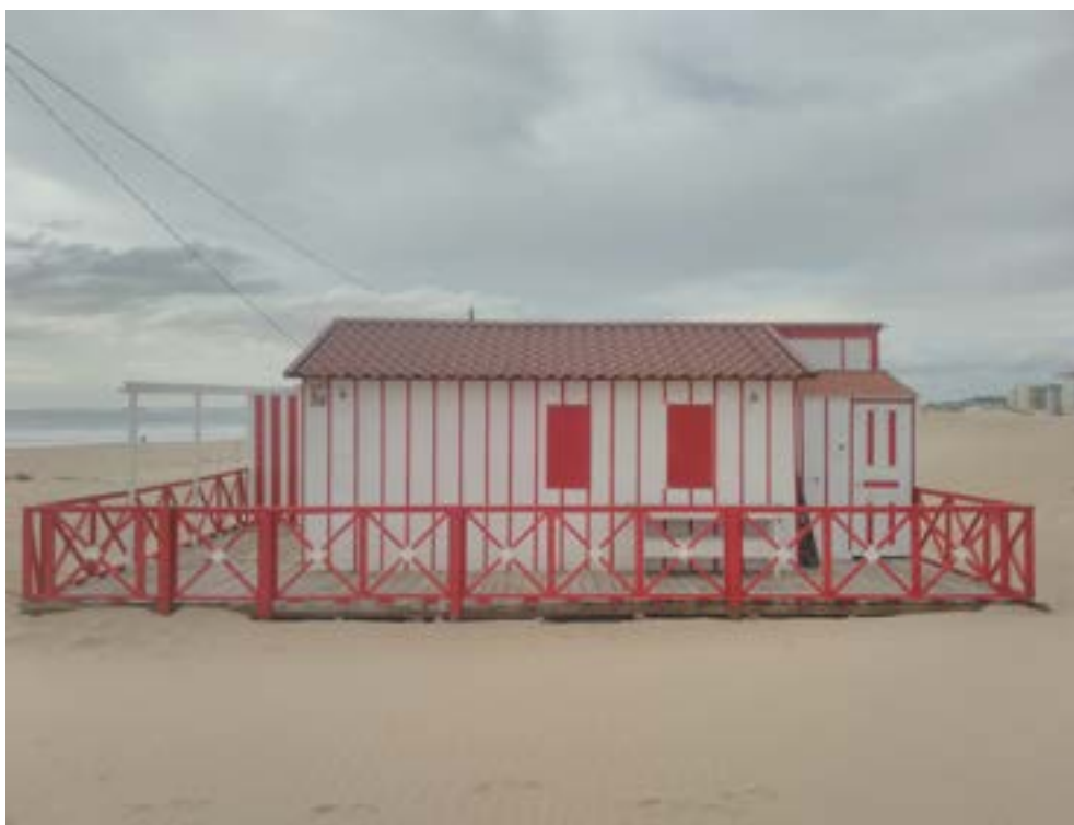
Figura 151 - Cabana de pescadores, recuperada pelos Arquitetos Sem Fronteiras-Portugal - assentamento da estrutura de madeira sobre o areal da praia (Novembro 2020)
