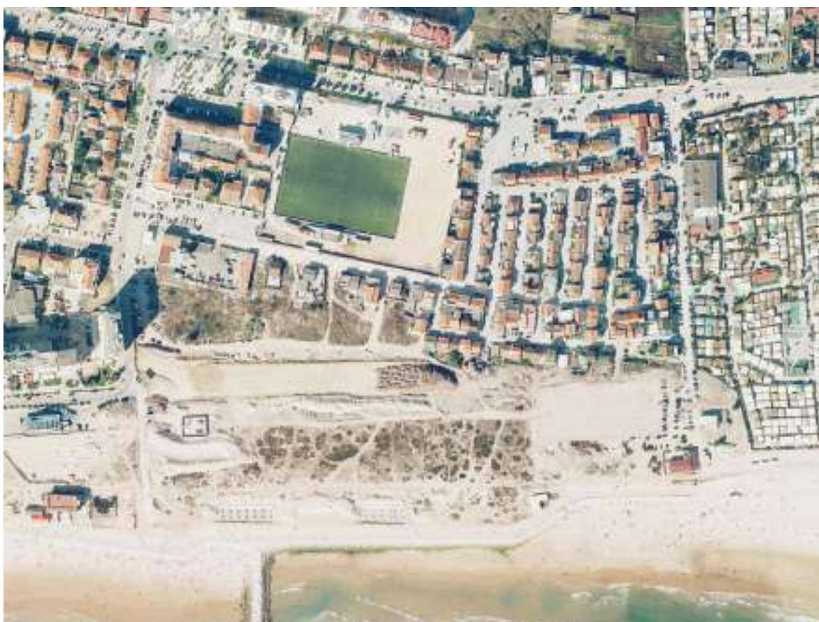
Figura 207 - A faixa de dunas, na qual se propõe criar o Pólo das Pescas, já durante a implementação do programa Costa Polís; construção das fundações dos novos apoios de praia e da nova lota; a unidade desta faixa dunar desapareceu (2007) - Google Earth Pro
