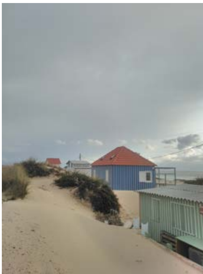
Figura 83 - Cabanas de pescadores, recuperadas pelos Arquitetos Sem Fronteiras-Portugal (Dezembro de 2020)
