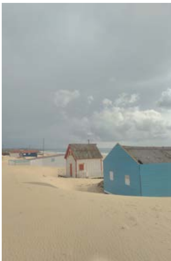
Figura 145 - Cabanas de pescadores, recuperadas pelos Arquitetos Sem Fronteiras-Portugal - assentamento nas “depressões” da duna (Novembro de 2020)
