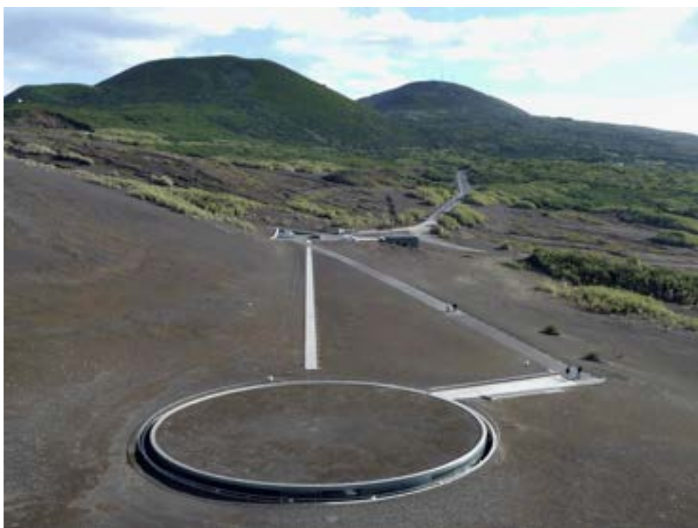
Figura 178 - Nuno Ribeiro Lopes, Centro de Interpretação do Vulcão dos Capelinhos, Horta, Açores (2006-2008) - vista aérea do projeto, com destaque para os caminhos pedestres e para o gesto, delicado, de marcação da presença do edifício, enterrado - através de uma abertura contínua de luz zenital
