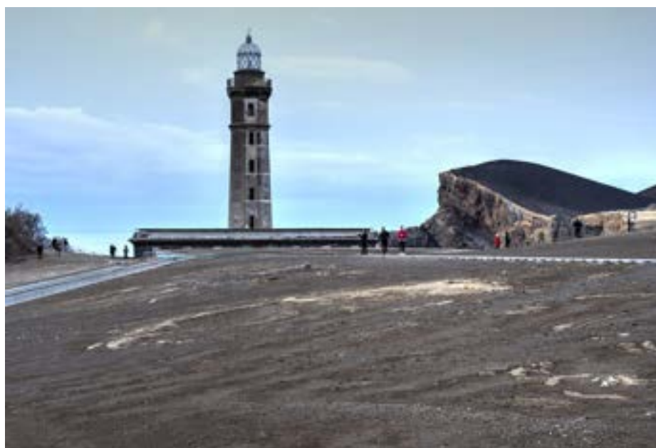
Figura 183 - Nuno Ribeiro Lopes, Centro de Interpretação do Vulcão dos Capelinhos, Horta, Açores (2006-2008) - pormenor da articulação do projeto com a estrutura do antigo farol
