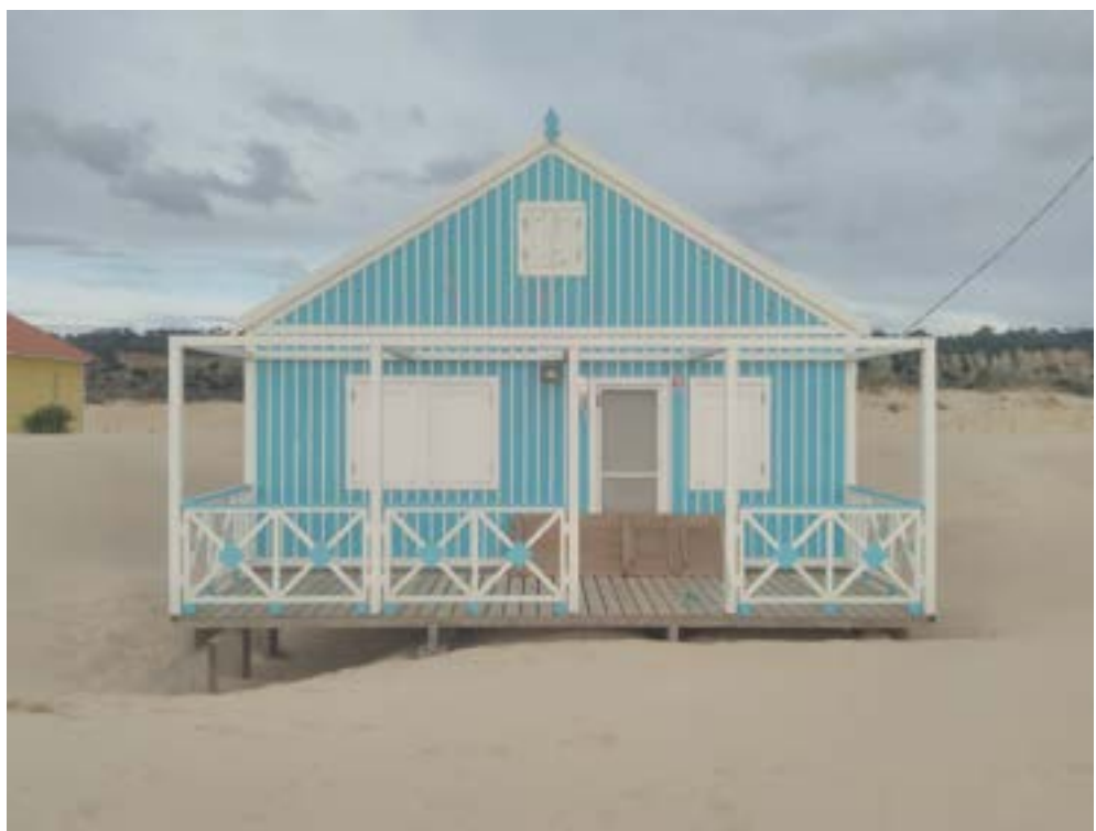
Figura 152 - Cabana de pescadores, recuperada pelos Arquitetos Sem Fronteiras-Portugal - assentamento da estrutura de madeira sobre o areal da praia (Novembro de 2020)
