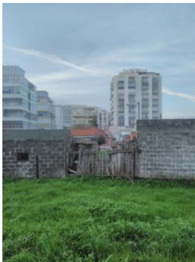
Figura 114 - A “invasão” do edificado, nas Terras da Costa (Novembro de 2020)
