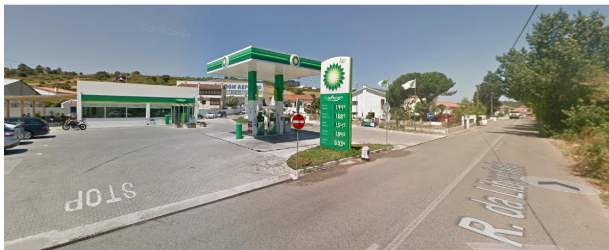
Figura 5.4: Posto de Combustível de Runa/Torres Vedras
