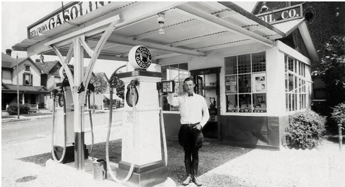
Figura 5.3: Antigo posto de combustível
