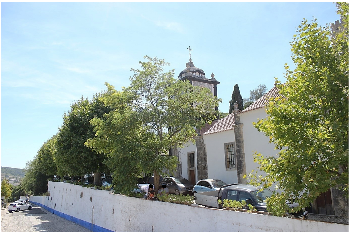
Figura 11 – Captura de fotografia da fachada lateral da Igreja de S. João. (Fotografia de autor).
