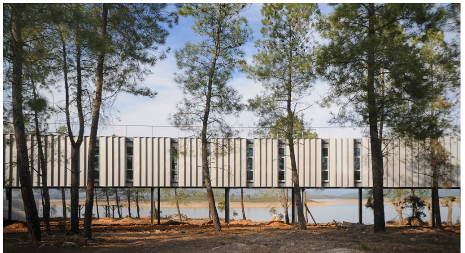
Figura 83 - Fotografia no espaço interior do projeto. [Archdaily]
