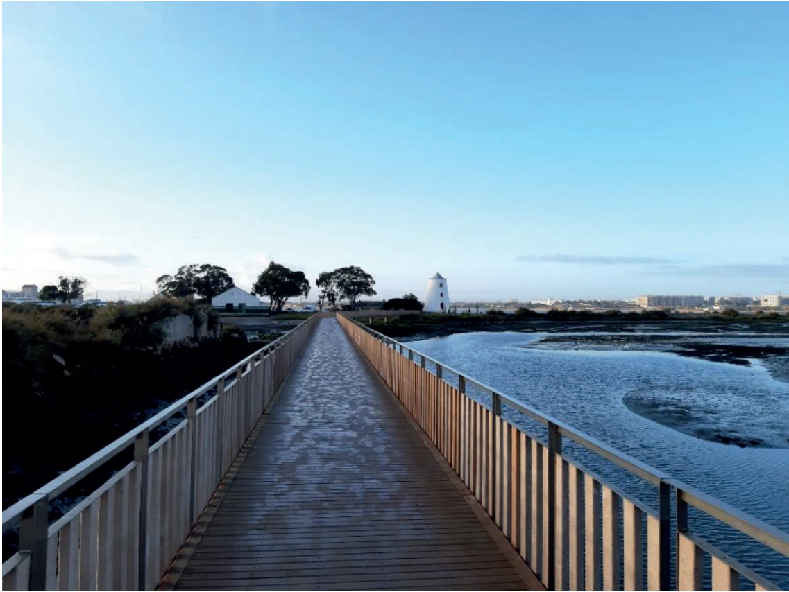
Figura 21 Moinho de vento e caldeira do moinho de maré
