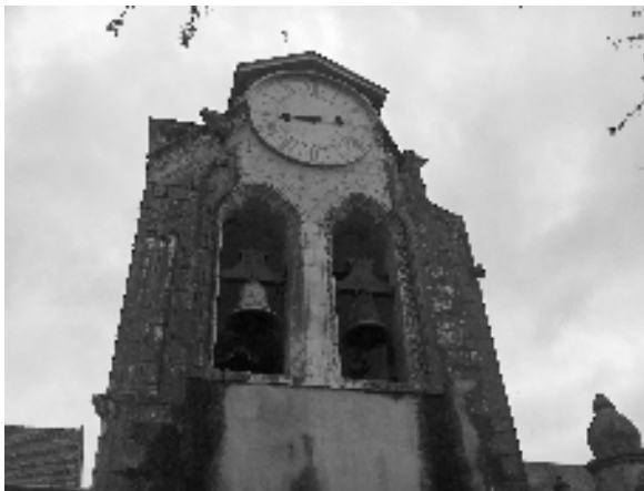
Fig. 66 – Torre da Igreja da N a Senhora do Pópulo anexa ao Hospital Termal de Caldas da Rainha. Foto: Autor.
