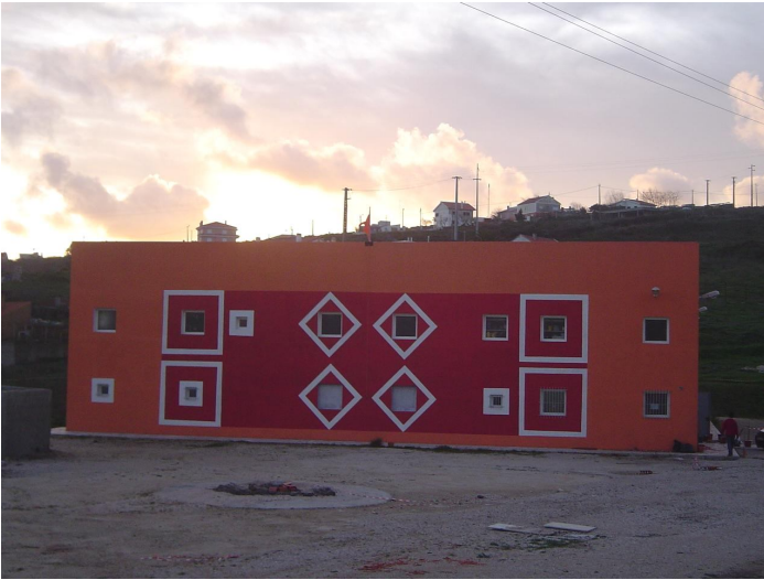
3. Edifício provisório do Templo de Shiva.
