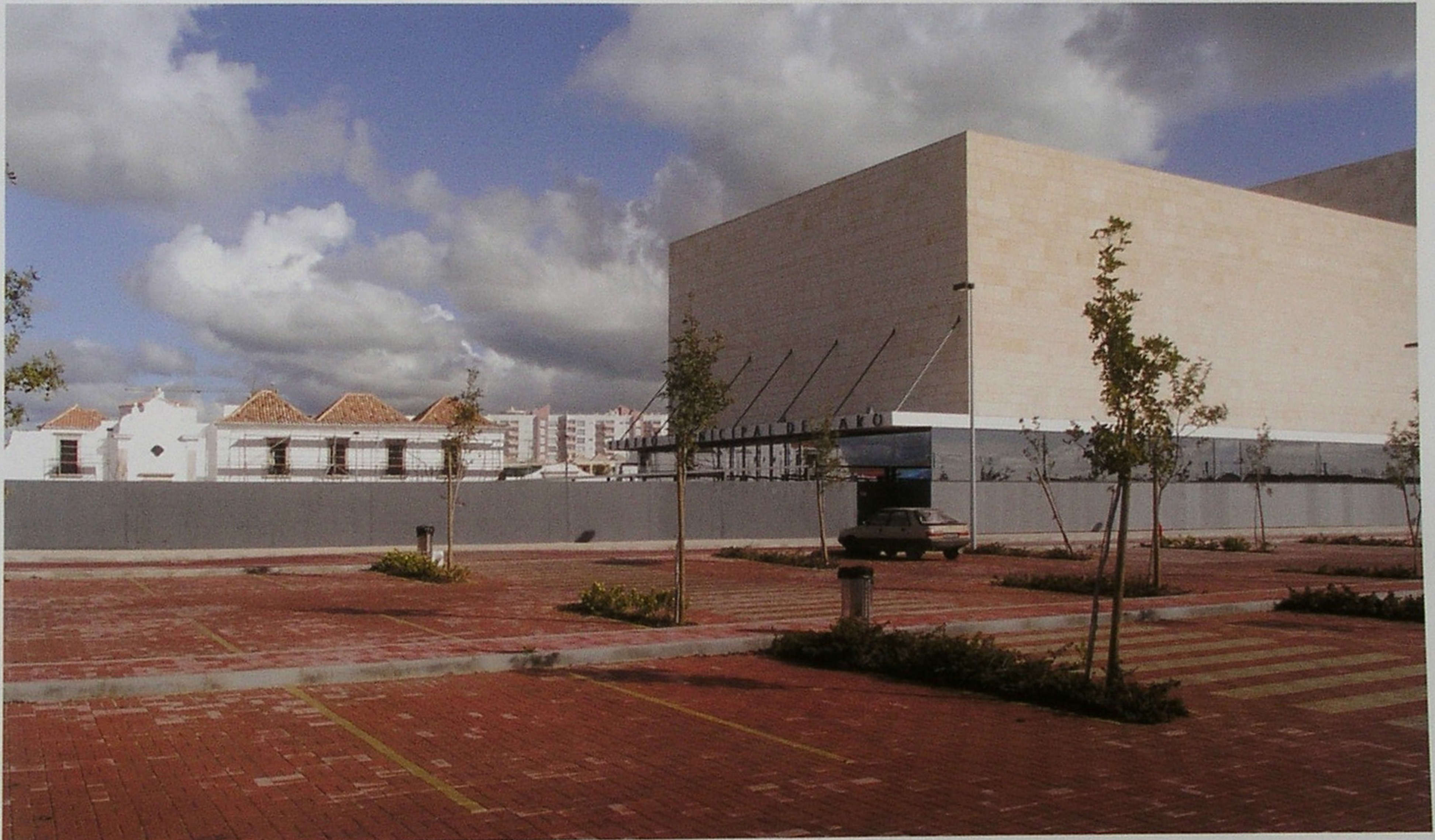
3 Vista sul do teatro com o solar.
