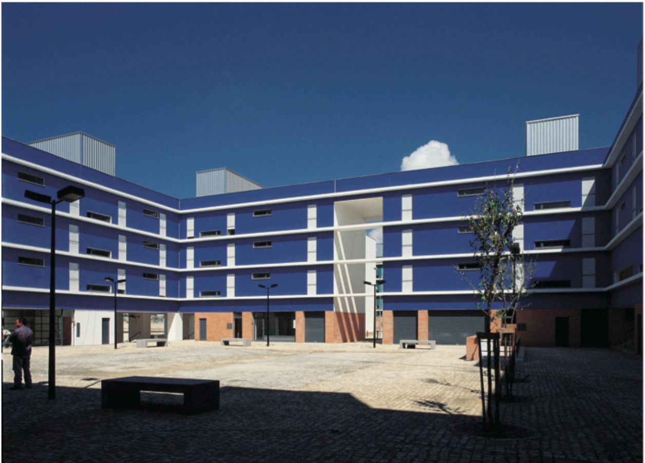
Interior azul na Unidade B, PER -Travessa Sargento Abílio
