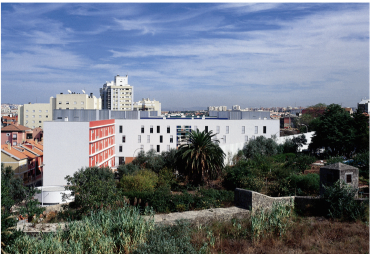
Fotografia no enfiamento Sul/Norte PER-Travessa Sargento Abílio
