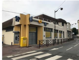
Ravalement Poste de Brétigny
