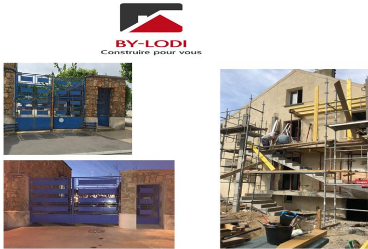
Elargissement passage et nouveau portails Poste de Dreveil
