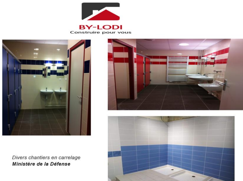
Figura 12 - Exemplos de obras realizadas
