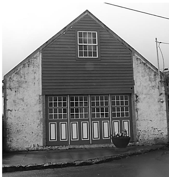
Figura 1 – Edifício vernacular, Ribeirinha, Ilha do Pico (Açores)
