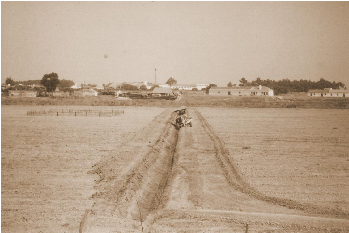
Figura 138 - Abertura de valas na Lezíria Grande, s/d (Fonte: Arquivo da ABLGVFX)
