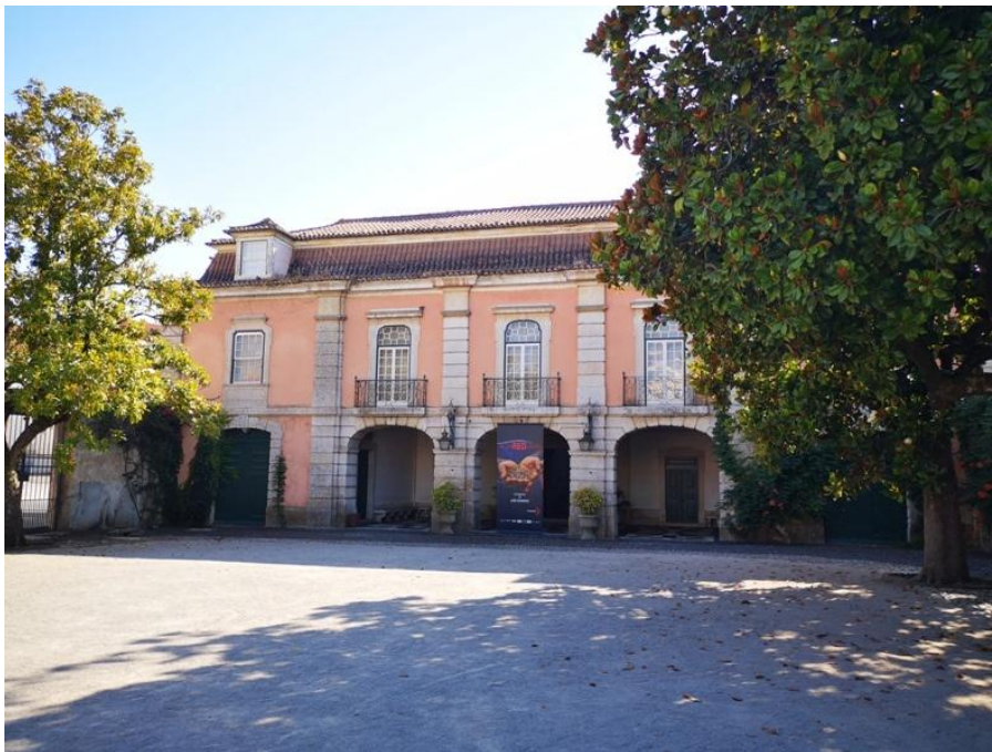
Figura 63 - Palácio Angeja, Lumiar, Lisboa (Fotografia do Autor, 2020)
