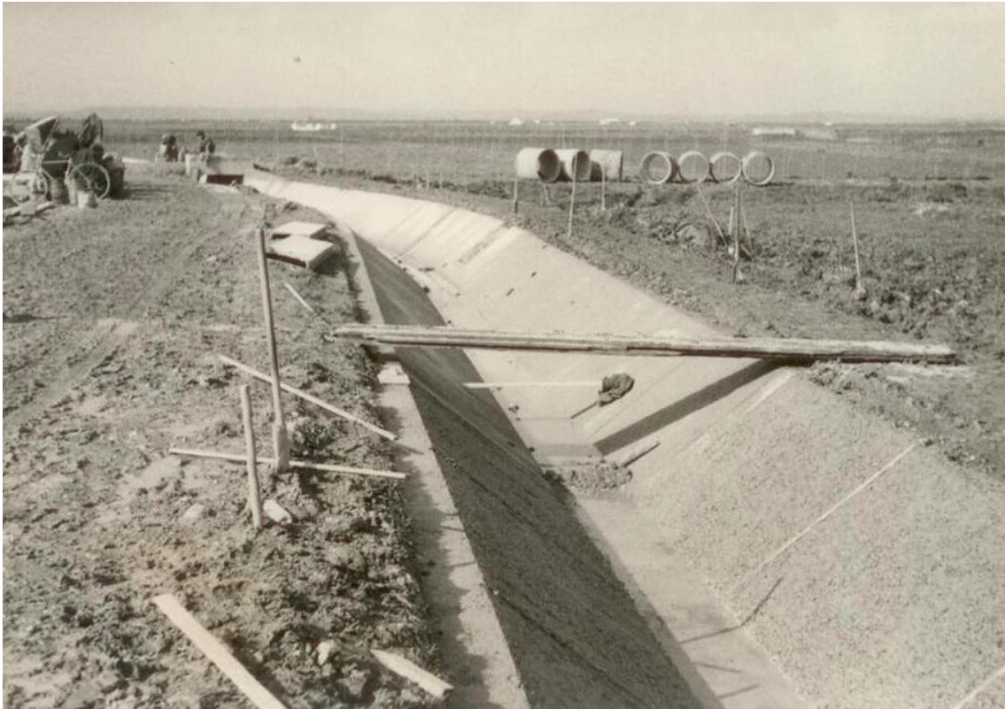
Figura 24 - Construção de um canal de rega. Lezíria Grande, s/d (Fonte: Arquivo da ABLGVFX)
