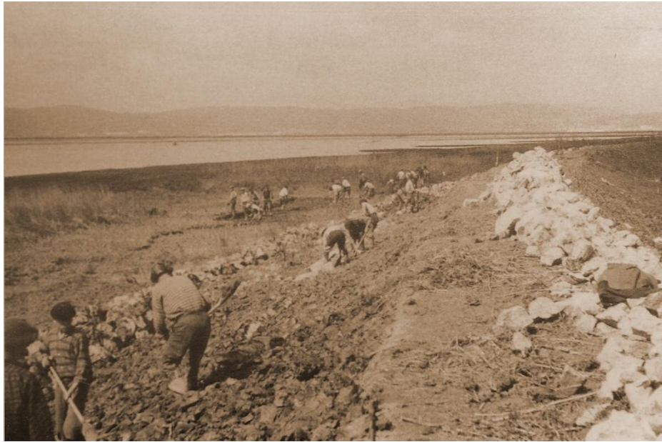
Figura 123 - Construção do dique da Lezíria Grande, s/d (Fonte: Arquivo da ABLGVFX)
