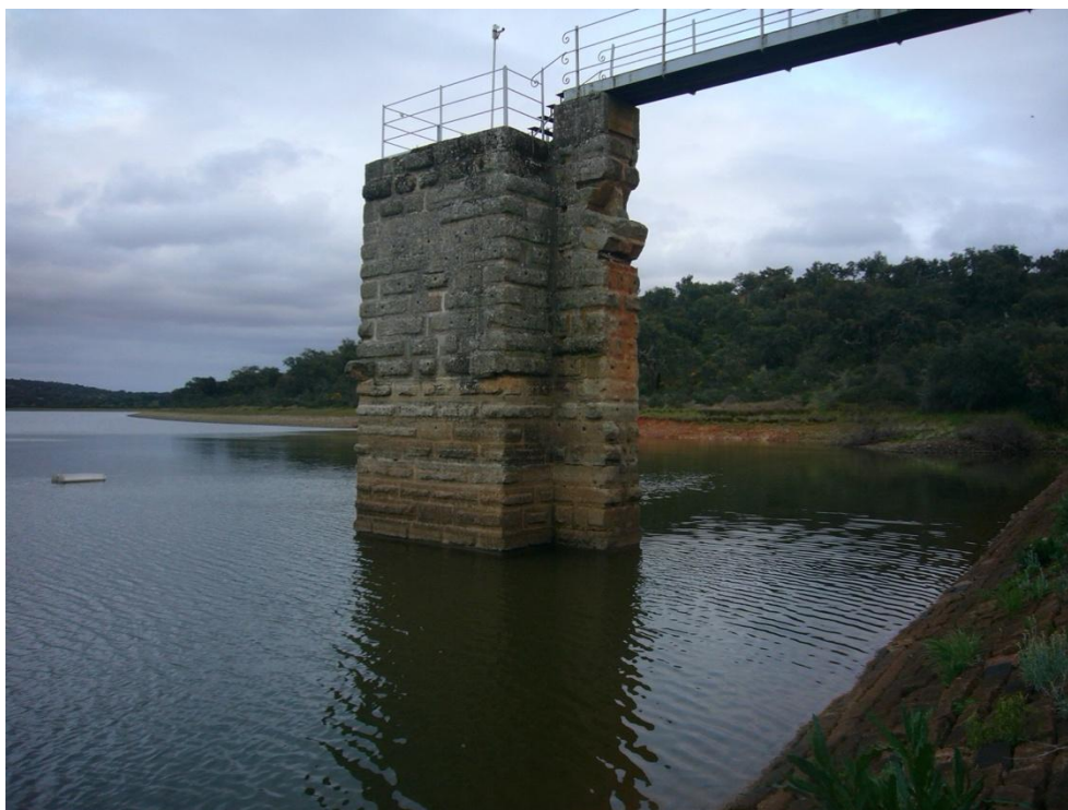
Figura 33 - Mecanismo romano para a elevação de água. Barragem de Cornalvo. Arredores de Mérida. (© José Luís Saldanha, s/d)
