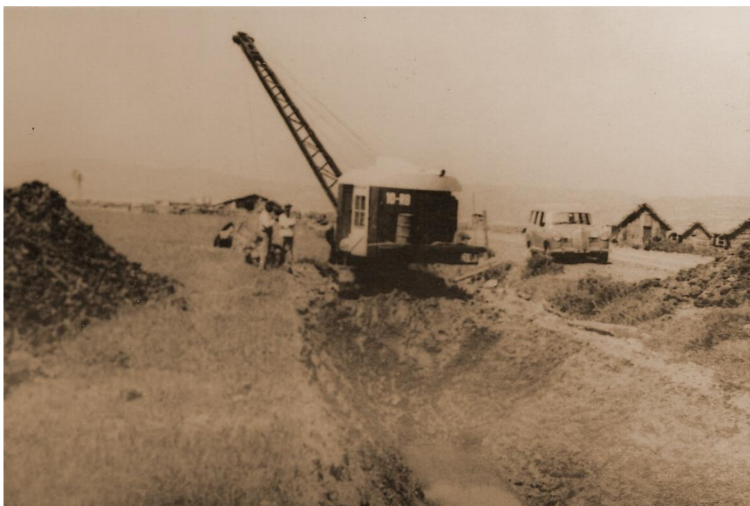
Figura 120 - Abertura de valas na Lezíria Grande, s/d (Fonte: Arquivo da ABLGVFX)
