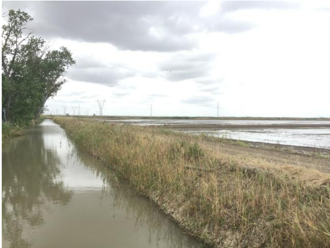
Figura 131 - Canal de Rega. Lezíria Grande (Fotografia do Autor, 2017)
