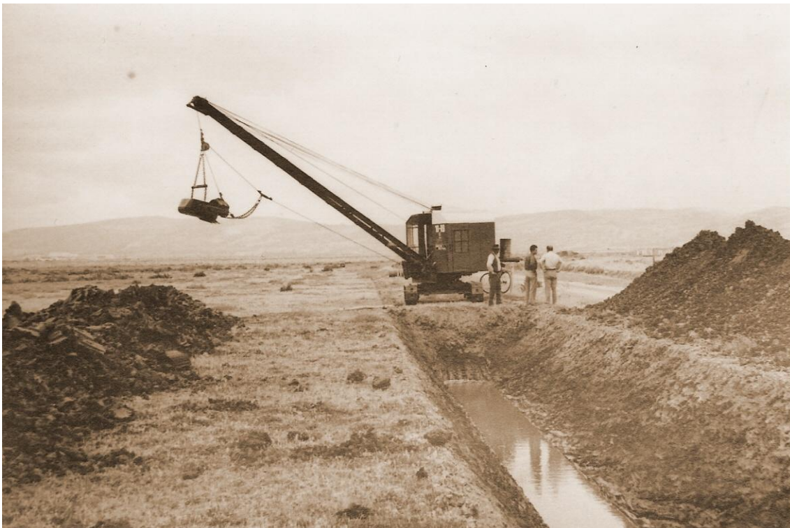
Figura 122 - Abertura de valas na Lezíria Grande, s/d (Fonte: Arquivo da ABLGVFX)
