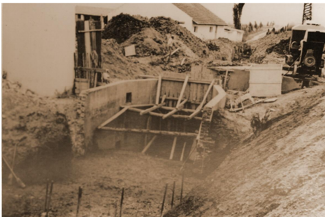
Figura 121 - Construção de uma comporta. Lezíria Grande, s/d (Fonte: Arquivo da ABLGVFX)
