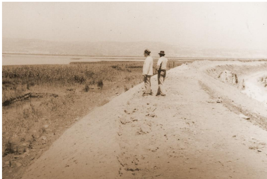
Figura 124 - Construção do dique da Lezíria Grande, s/d (Fonte: Arquivo da ABLGVFX)
