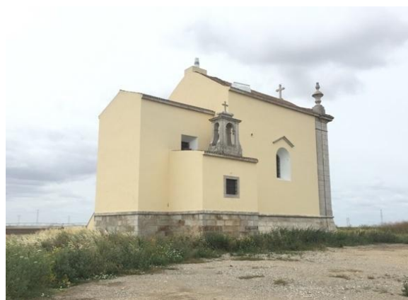
Figura 76 - Exterior de Ermida de São José, Vila Franca Xira (Fotografias do Autor, 2018)
