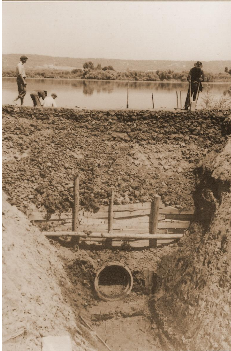
Figura 125 - Construção de uma comporta. Lezíria Grande, s/d (Fonte: Arquivo da ABLGVFX)
