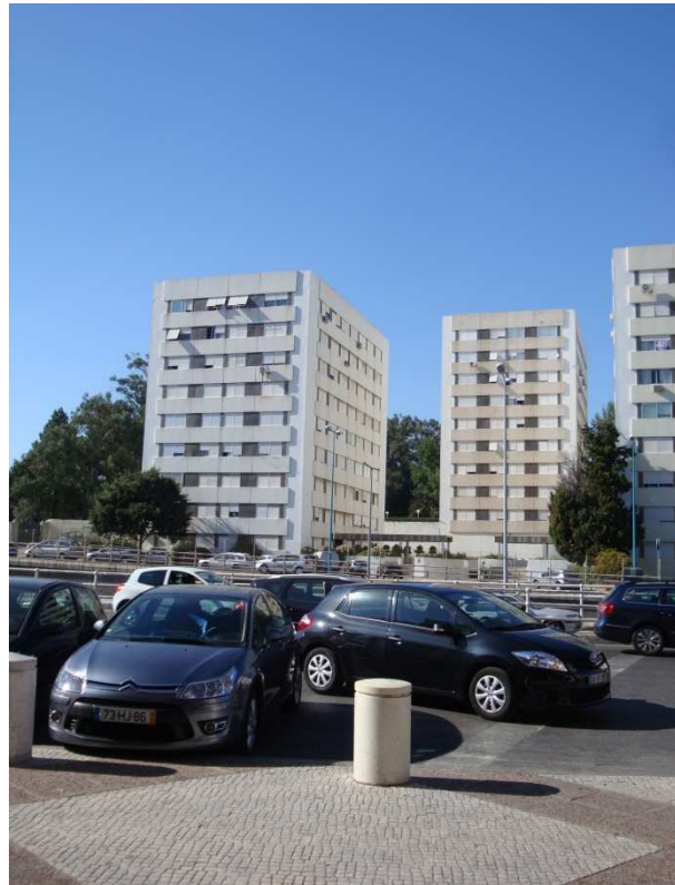
[31] . Fotografia dos edifícios da autoria do arquitecto Fernando Silva, na segunda fase da Urbanização Quinta dos Condes de Carnide.
