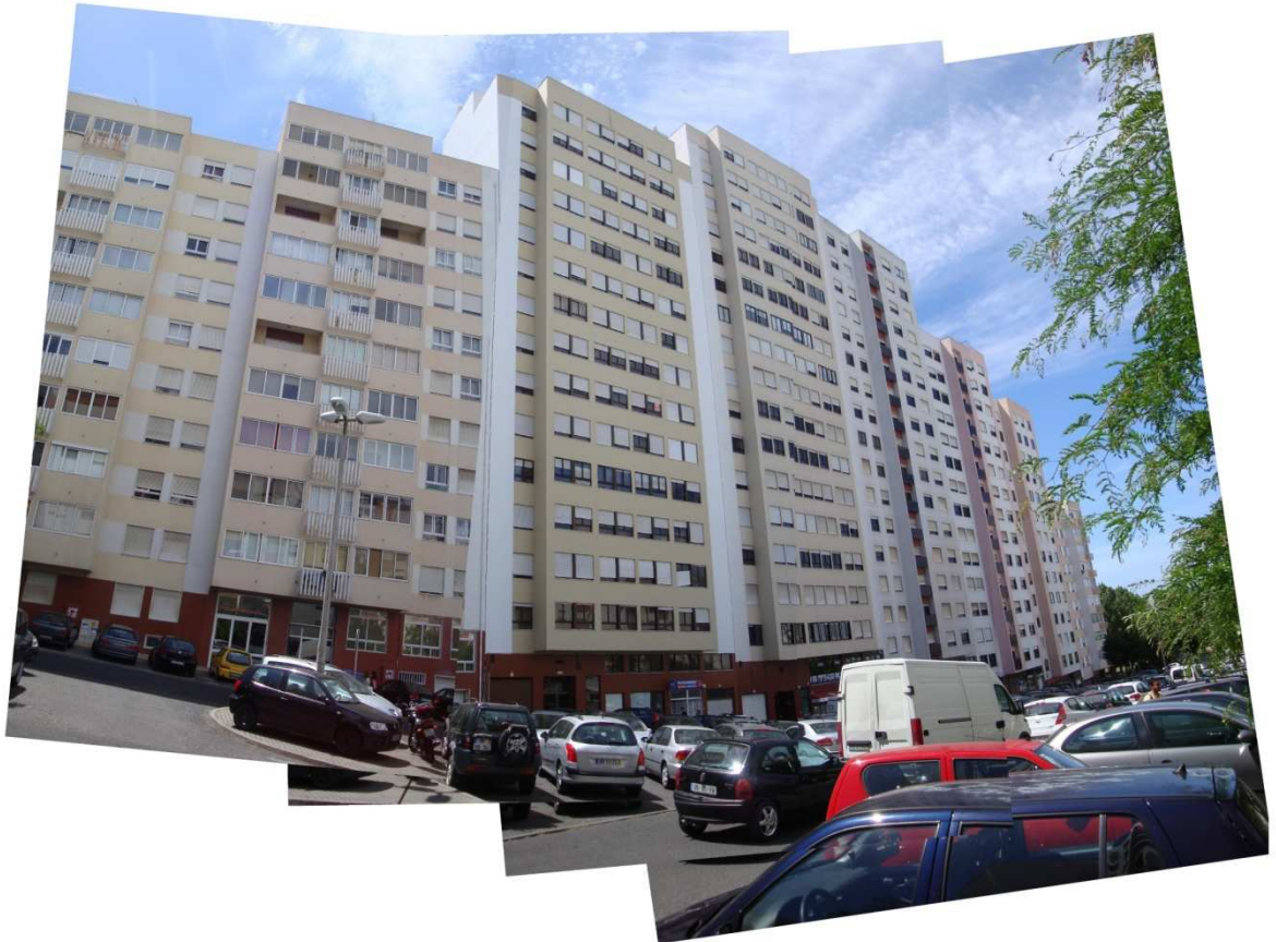
[48] . Fotografia da Urbanização Quinta Grande de Alfragide.
