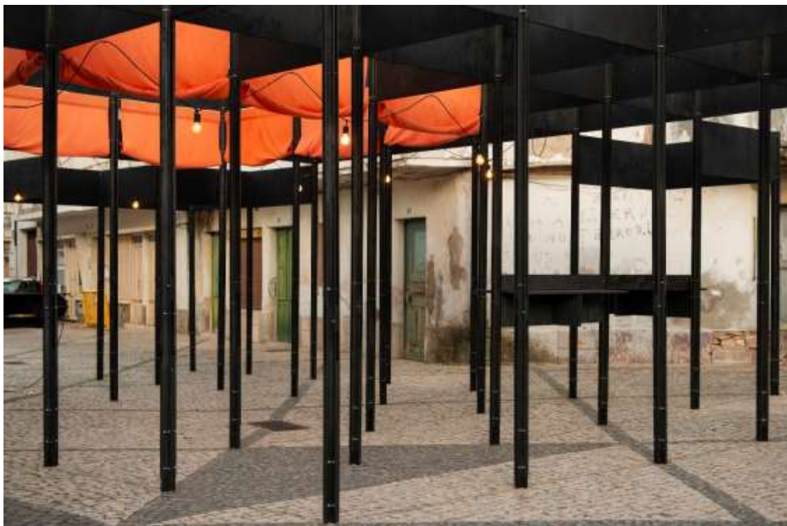
Figura 4. Pavilhão ALBERTO: vista do espaço interior e da “floresta” de pilares
