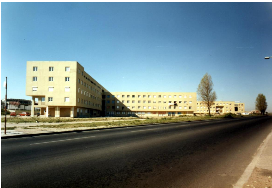
Fig. 4 – Vista do conjunto do Bairro na Quinta das Fonsecas – Blocos A e B Fonte: Fundação Marques da Silva, Espólio do Raúl Hestnes Ferreira
