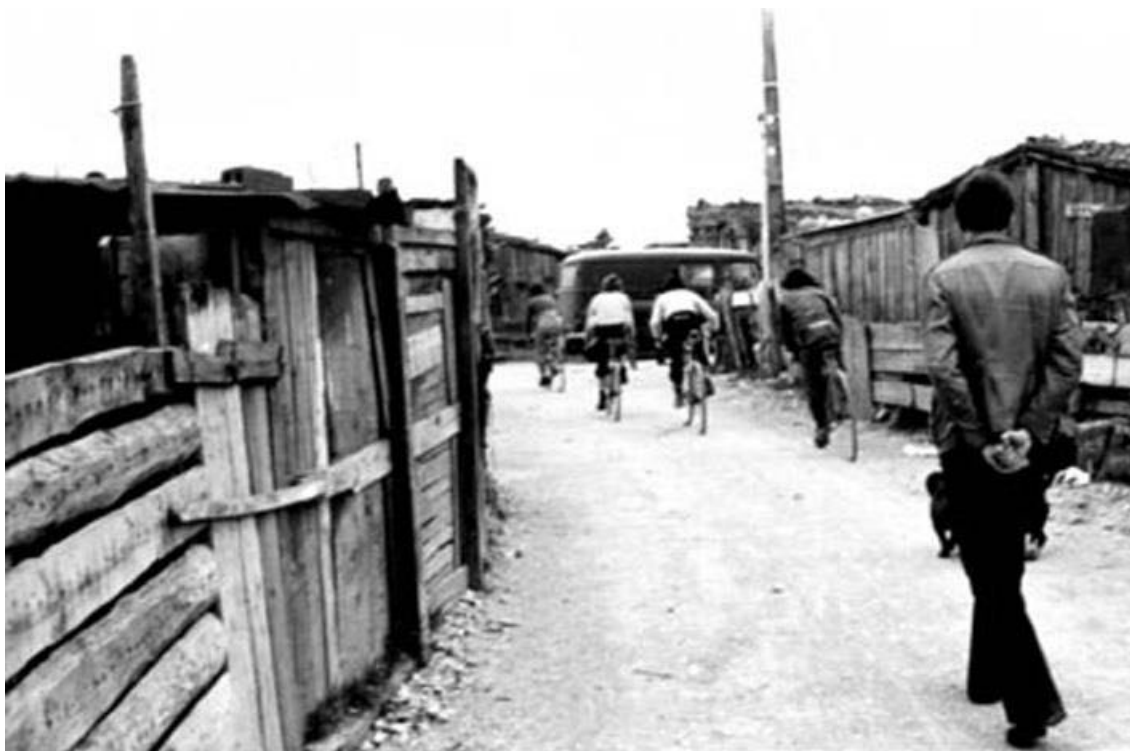
Fig. 3 – Vista panorâmica sobre o Bairro na Quinta das Fonsecas Fonte: Fundação Marques da Silva, Espólio do Raúl Hestnes Ferreira
