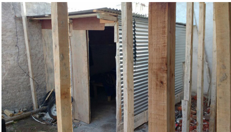
Figura 3: Vivienda. Obrador en Playa Unión, Rawson
