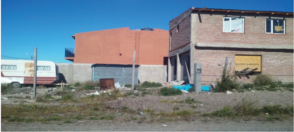
Figura 5: Casilla y obra. Playa Unión, Rawson
