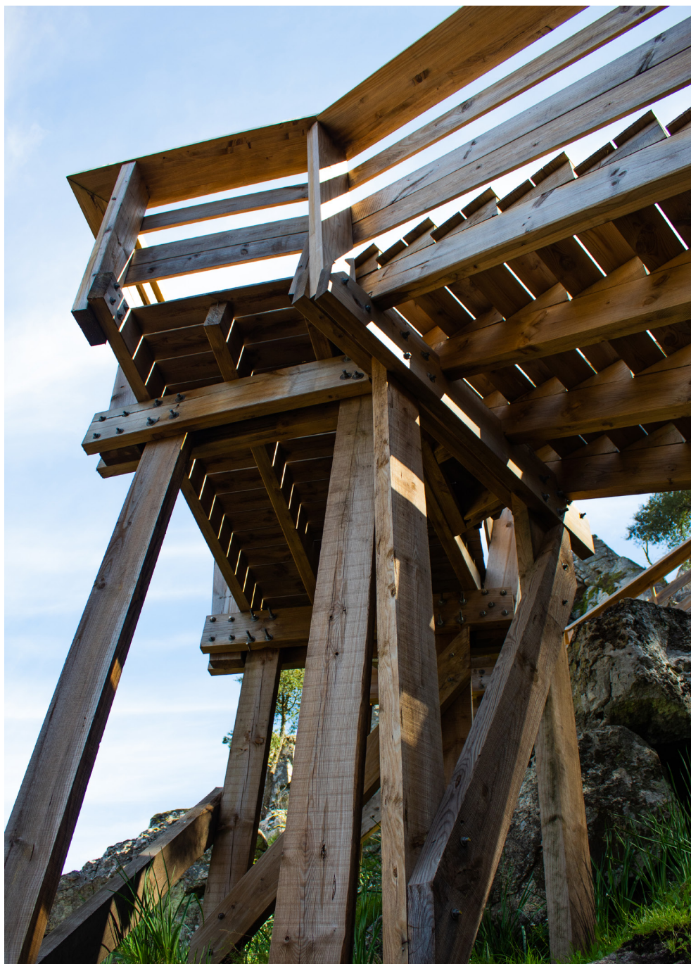
Fotografia em pormenor dos Passadiço do Paiva, projeto do Gabinete Dst group, imagem da autoria de António Alves captada a (02.03.2019)
