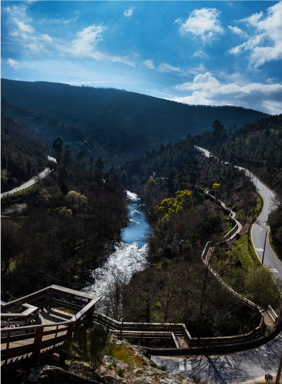
Fotografia dos Passadiço do Paiva, projeto do Gabinete Dst group, imagem da autoria de António Alves captada a (02.03.2019)
