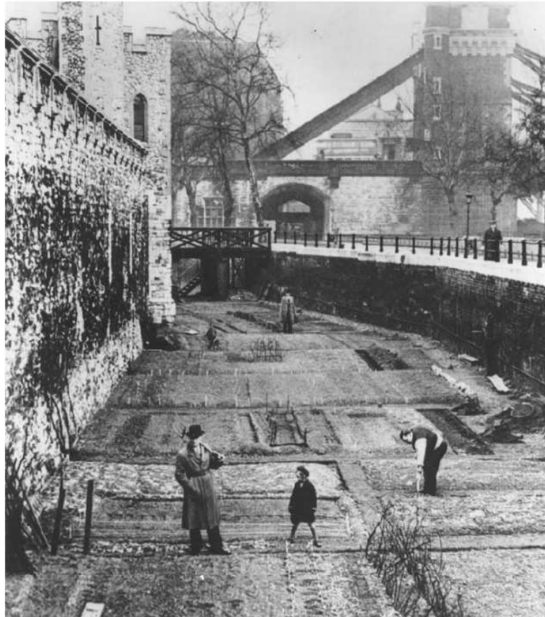
Figura 1.3 - Torre de Londres, 1939-1945
