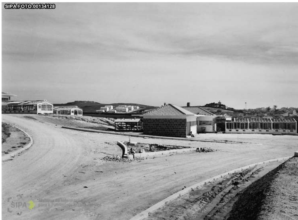
Figura 3.10 - Construção da EAN, 1962
