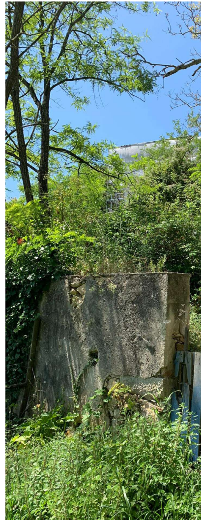
Figura 3.16 - Degradação das in
