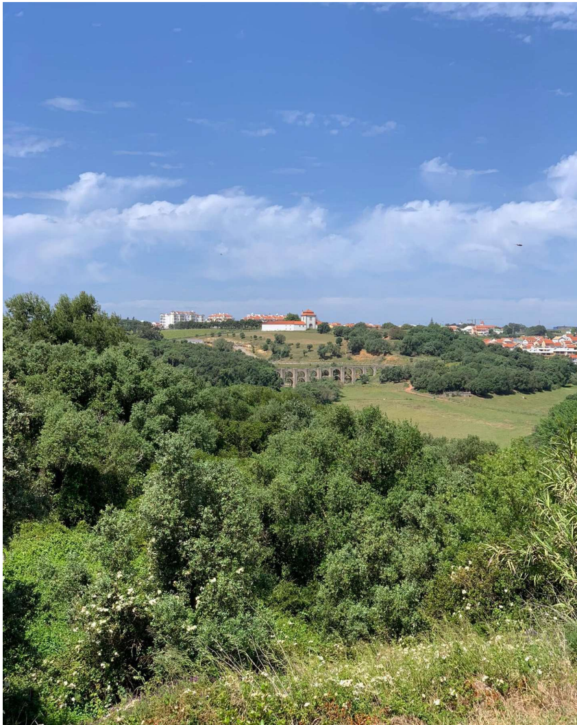
Figura 2.19 - Abegoaria e Aqueduto do Arneiro, nos terrenos da antiga Quinta de Recreio do Marquês de Pombal
