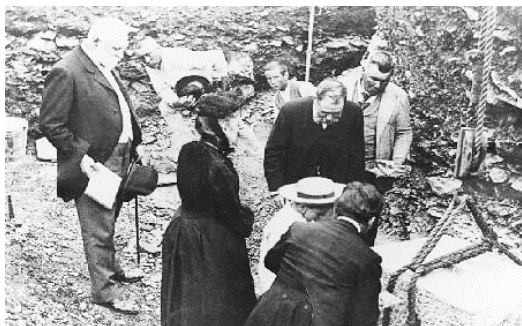
Figura 2.05 – D. Claudina Chamiço na cerimónia de lançamento da primeira pedra, 7 de agosto de 1901 351
