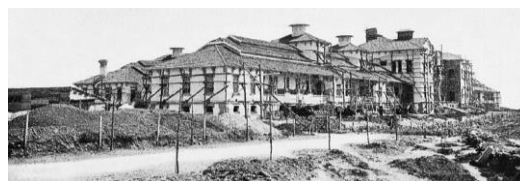
Figura 2.06 – Sanatório de Sant'Ana em construção, 1904 354
