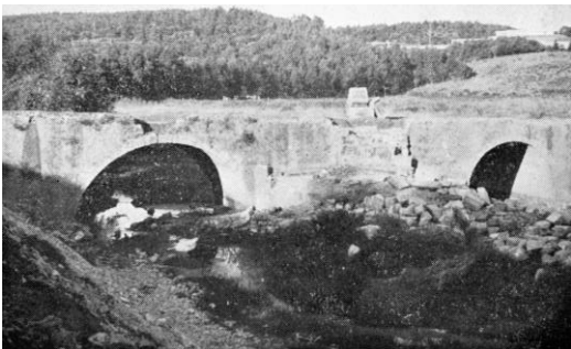
Figura 2.57 – Parapeito desnudado, cruz apeada, pedras soltas com a derrocada (lado esquerdo). A mesma ponte sobre o Jamor com a sua Cruz que brada, depois do restauro (lado direito)
