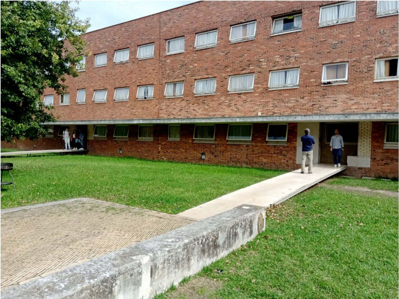
Fig. 10 - Fotografia com duas das entradas da residência do Complexo Residencial de Santiago
