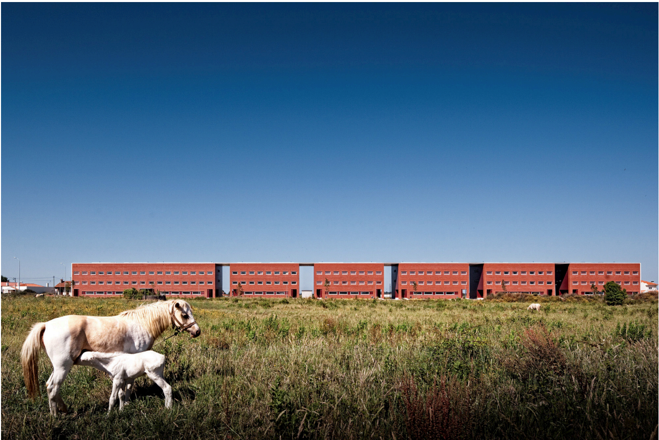
Fig. 13 - Vista da fachada voltada para para o campus
