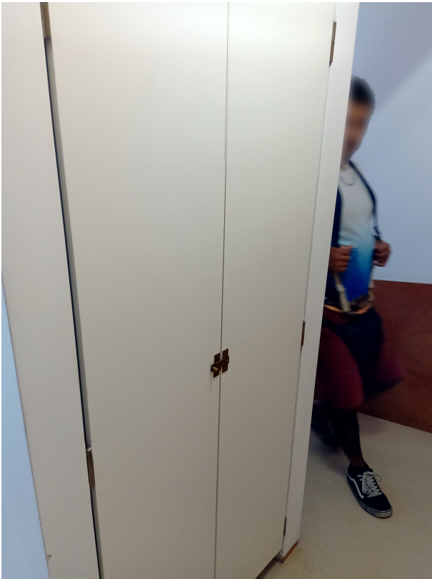
Fig. 17 - Fotografia do armário que fica por detrás da escada
