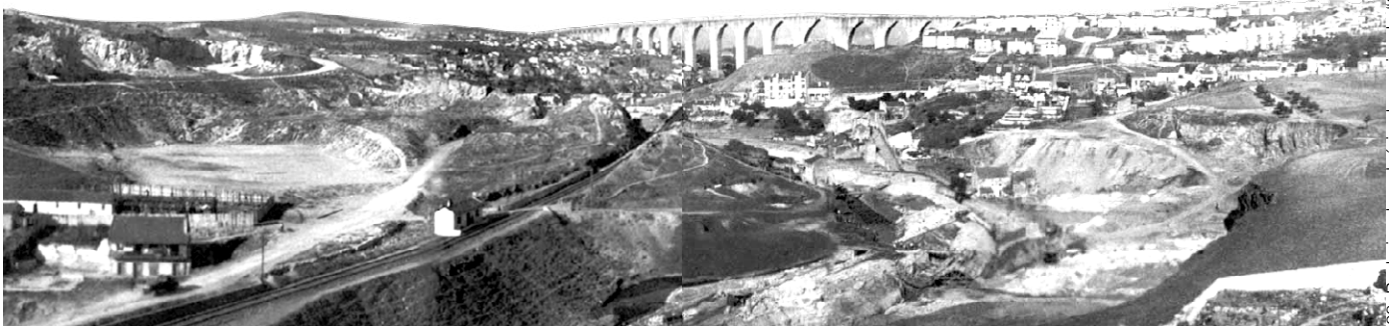
08. Pedreira de calcário denominada "Casal das Grades" no vale de Alcântara
