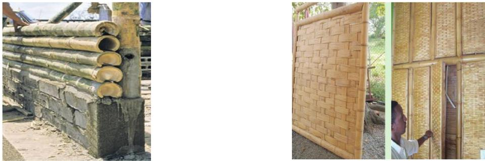
**Fig. 6.9: Paredes em colmos de bambu inteiros na posição horizontal; paredes de tecido de bambu**
