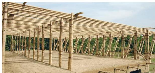
**Fig. 6.8: Pilares formados por dois colmos de bambu**
