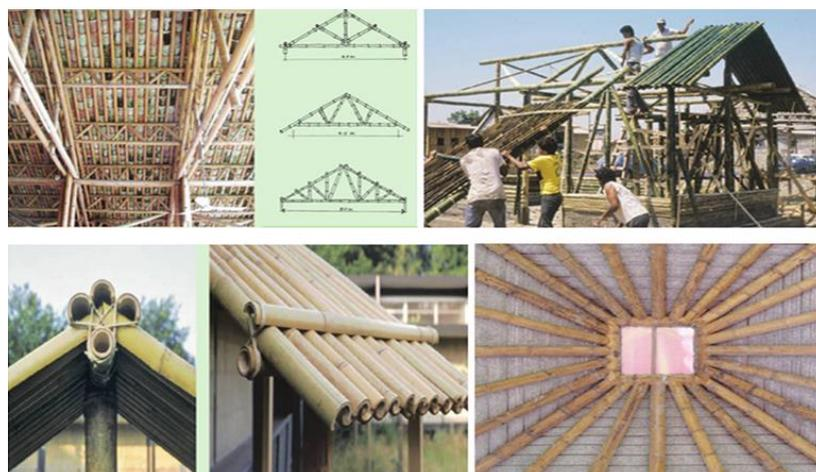
**Fig.6.11: Exemplo de cobertura em bambu cortado sobreposto, de forma piramidal**
