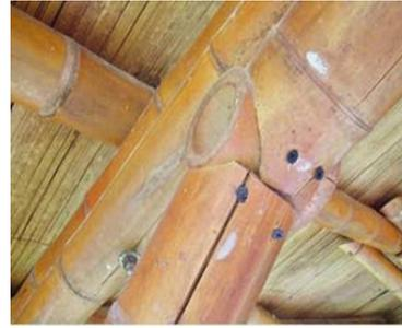
**Fig. 4.13: Conexão não-simétrica entre os colmos**
