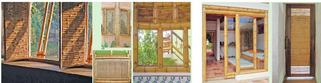
**Fig. 6.12: Janelas e portas em bambu**
