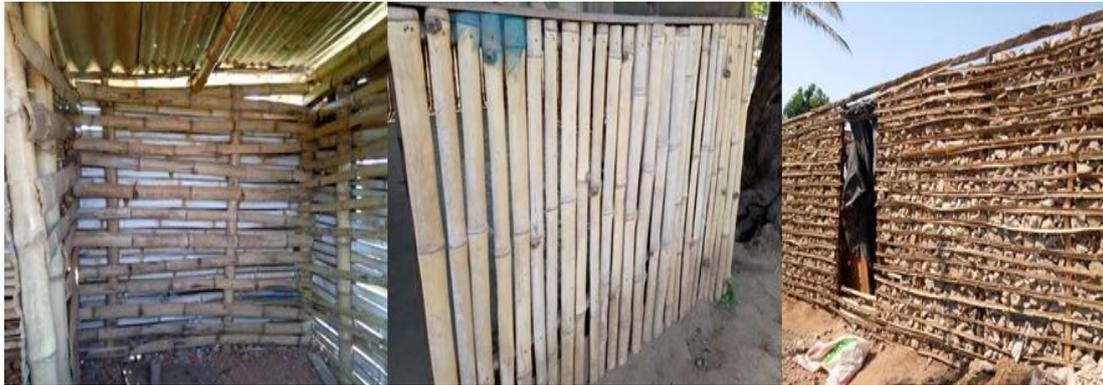
**Fig. 6.3: Estruturas em bambu não-tratado em contacto direto com o solo e embutido no cimento**
