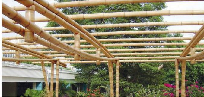
**Fig. 6.10: Vigas formadas por conjunto de dois colmos de bambu**
