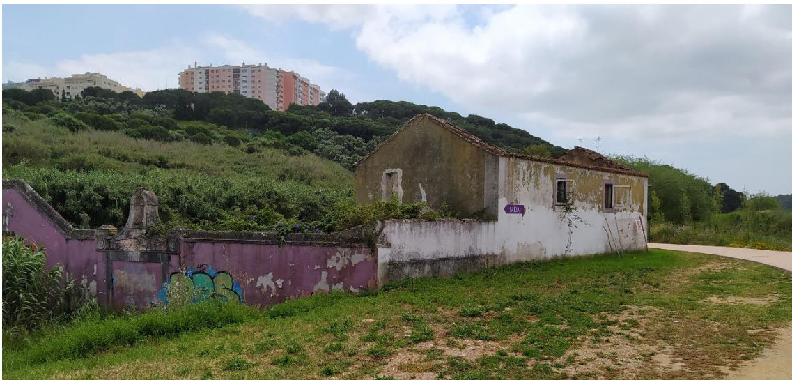
Figura 55 – Pórtico e edifício anexo. (Fotografia: Leonor Andrade, 2020)
