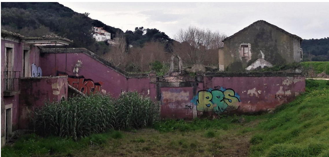
Figura 49 – Pórtico de conexão entre dois pátios. (Fotografia: Leonor Andrade, 2020)
