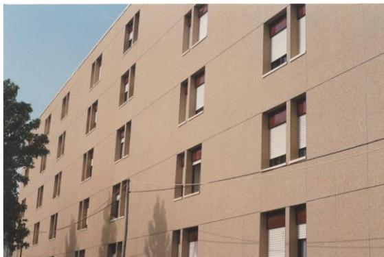
Fig.2 – Aspecto geral de uma fachada reabilitada com revestimento independente descontínuo com interposição de um isolante térmico no espaço de ar. DGEG (2004); *Reabilitação Energética da Envolvente de Edifícios Residenciais*; Brochura. Lisboa, Direcção Geral da Energia e Geologia, Lisboa; pág.10.
