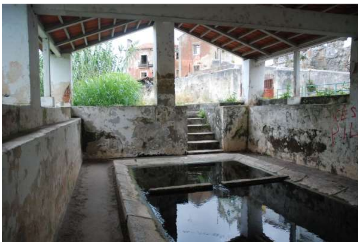
Figura 28 - Interior do lavadouro. (Fonte: Fotografia da autora em março 2020)
