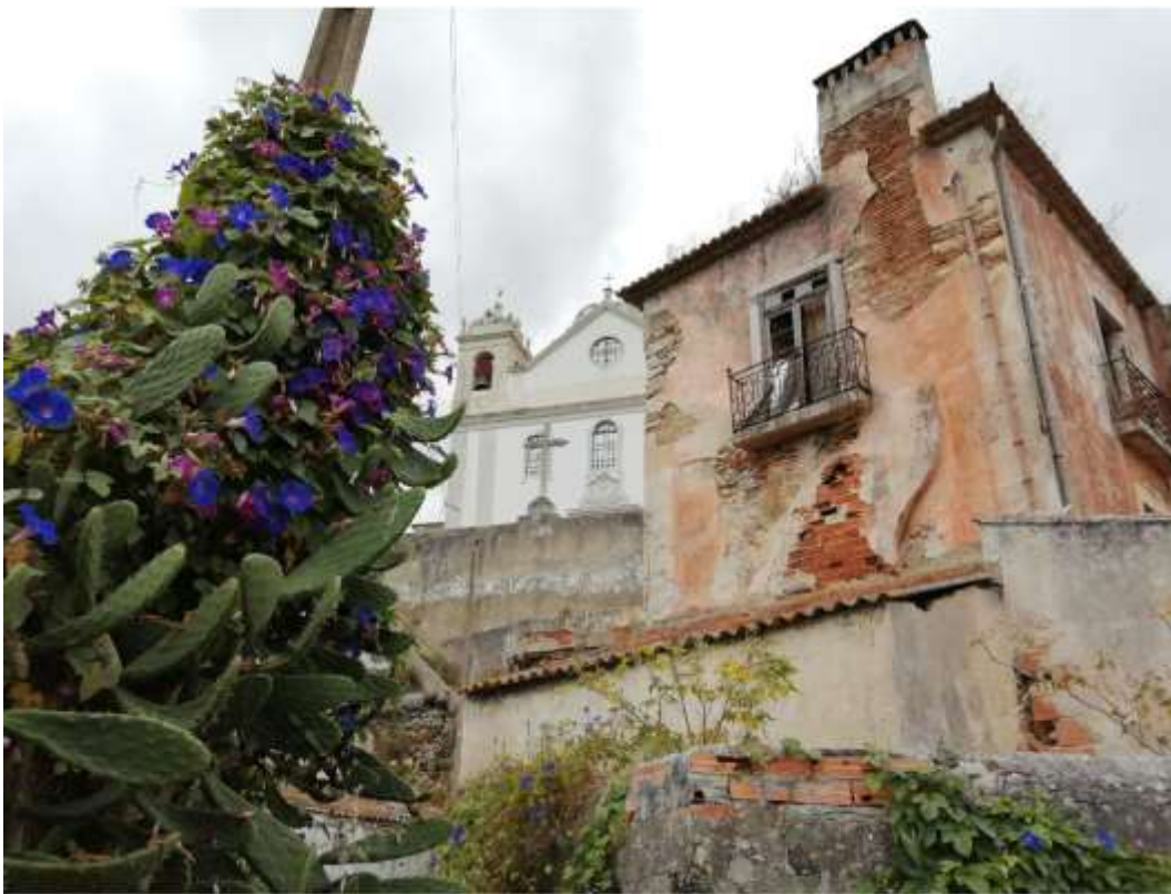
Figura 27- -Antiga Casa da Cooperativa à cota da Ribeira (+36 m) e a igreja em segundo plano sob a plataforma a meia-encosta. (FONTE: fotografia da autora em março 2020)
