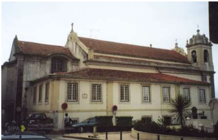
Figura 5 - Fotografia da Igreja de S. Pedro de Barcarena antes da sua recuperação em 2003. (FONTE: retirada do sítio do SIPA pertencente à DGPC, disponível em http://www.monumentos.gov.pt/Site/APP_PagesUser/SIPA.aspx?id=11876 )
