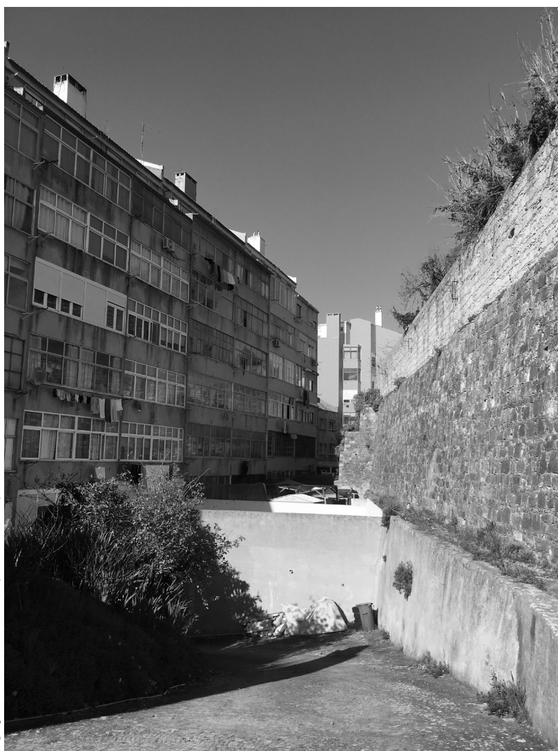
Ligação Travessa Giestal (vista interior)
