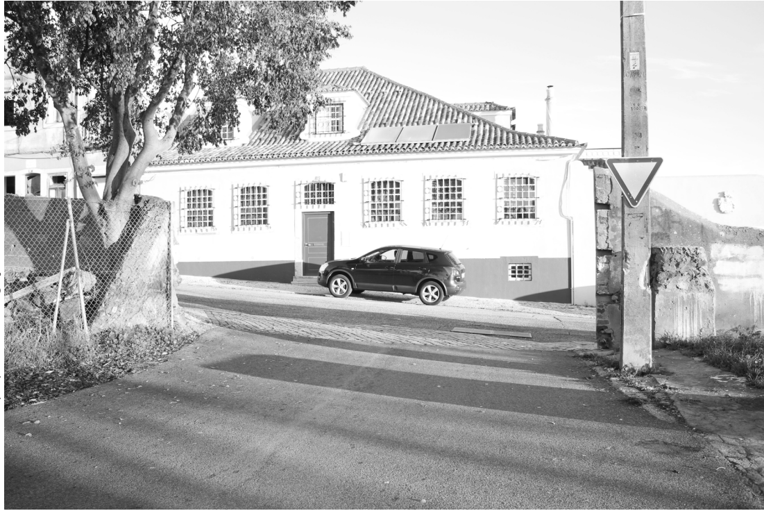
Edifício onde se propõem nova ligação
