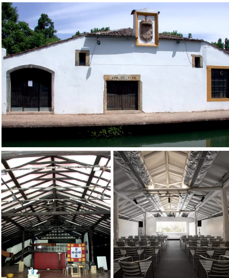
Fig.51 - Edifício E06, Sector 3, Levada de Tomar.
