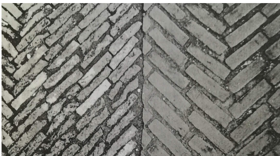
Fig.21 - Pavimento do interior da Central de Diesel, Autoria de Miriam Godinho
