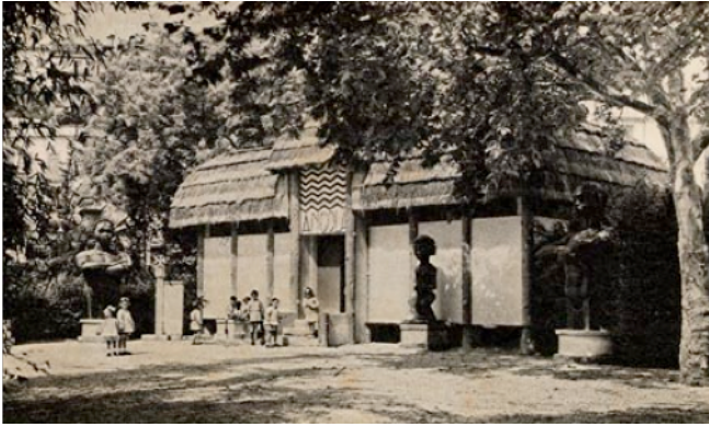
Figura 6: Pavilhão original de Angola, anos 40 do século XX, fotografia do espólio da FBB.
