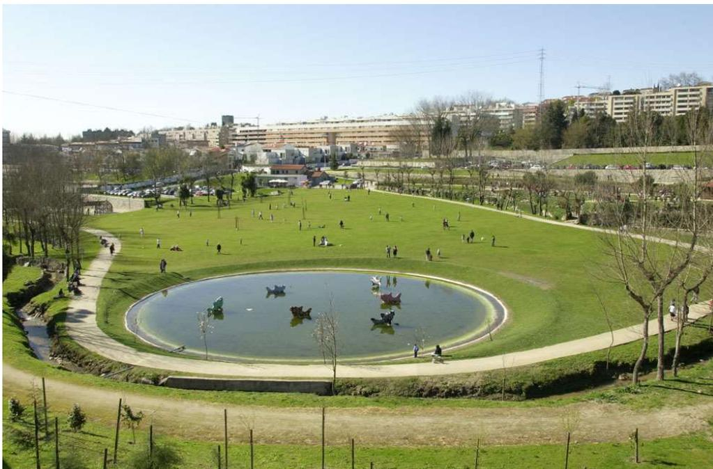
Figura 17 Bacia de retenção para a mitigação do risco de inundação em Guimarães (CMG, s.d.)
