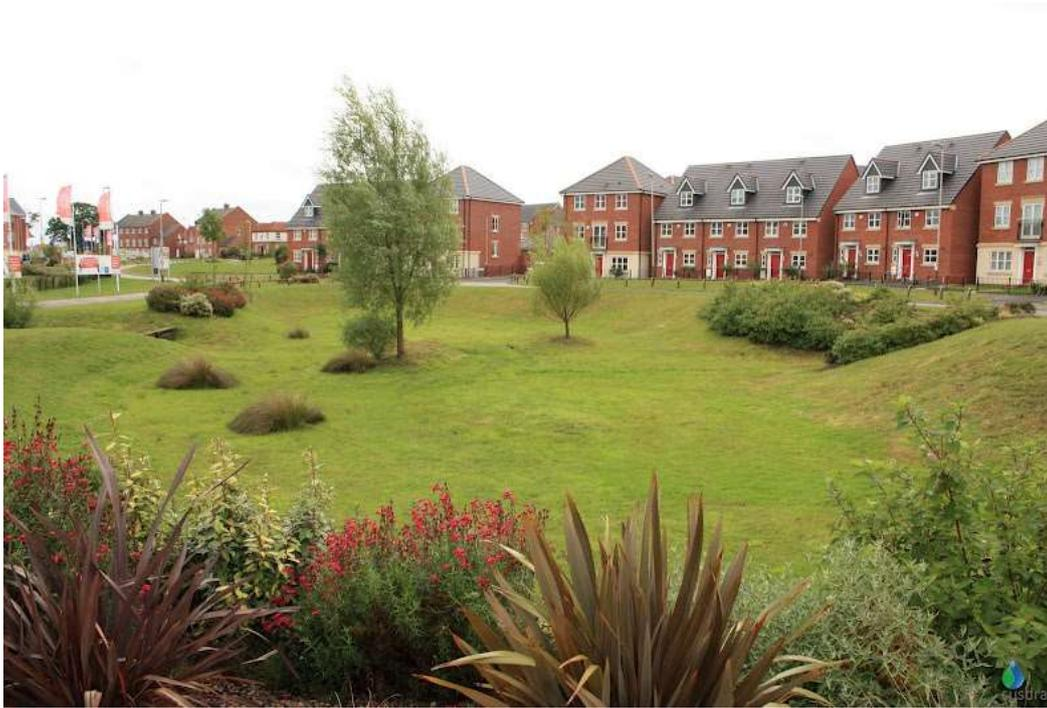
Figura 15 Exemplo de uma bacia de detenção (susdrain, s.d.)
