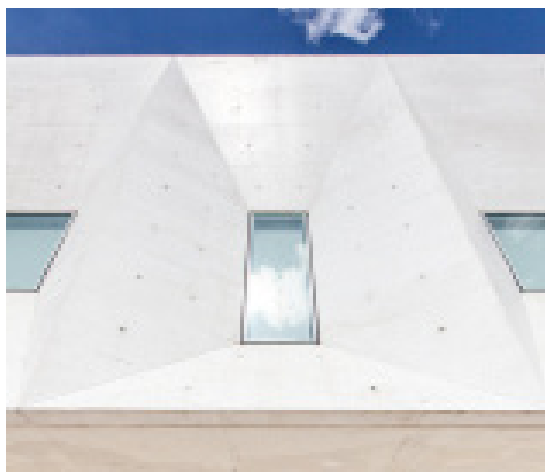
Figura 63 - Exemplo de revestimento exterior em betão estrutural branco
