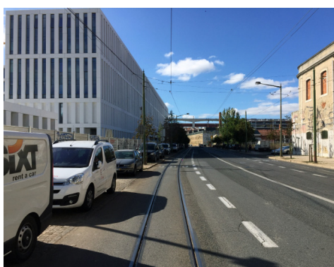
Figura 21 - Av. 24 de Julho
