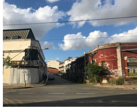
Figura 27 - Rua Vieira da Silva vista da Av. 24 de Julho
