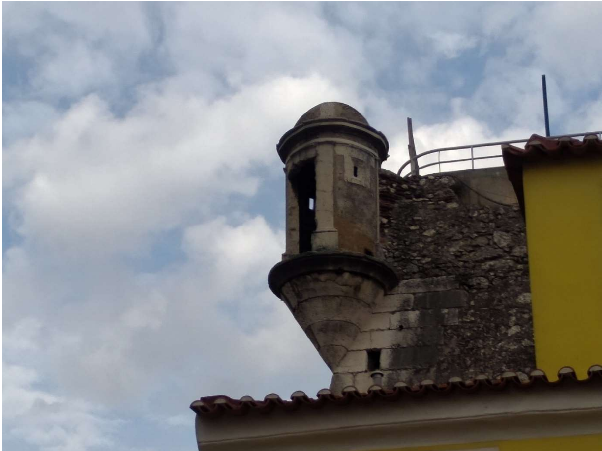
Figura 15 - Fotografia da guarita do Forte do Livramento (Fonte: Autor)
