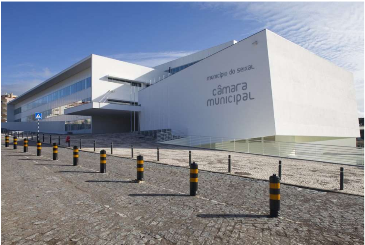
Figura 43 - Fotografia da entrada do edifício da Câmara Municipal do Seixal (Fonte: Archdaily)
