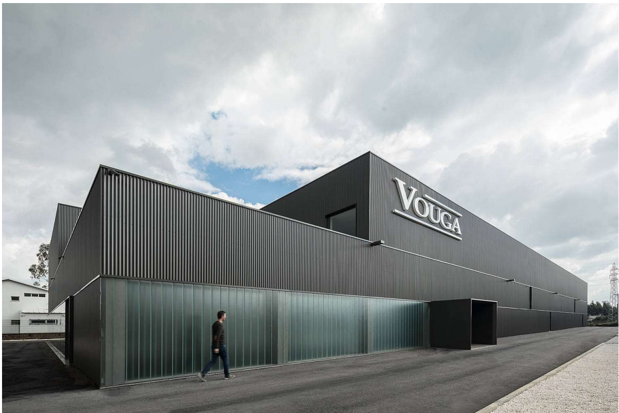
Figura 59 - Fotografia exterior do edificio Vouga (Fonte: Archdaily.com)
