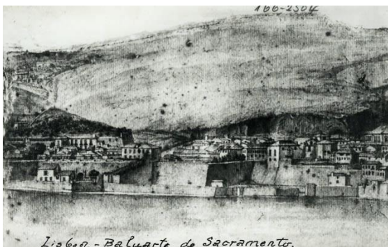
Figura 3. Baluarte do Sacramento em Alcântara, 1844
