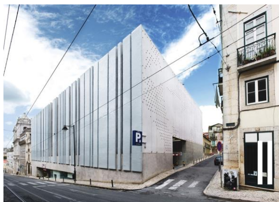
Figura 78, silo automóvel chiado, 2005
