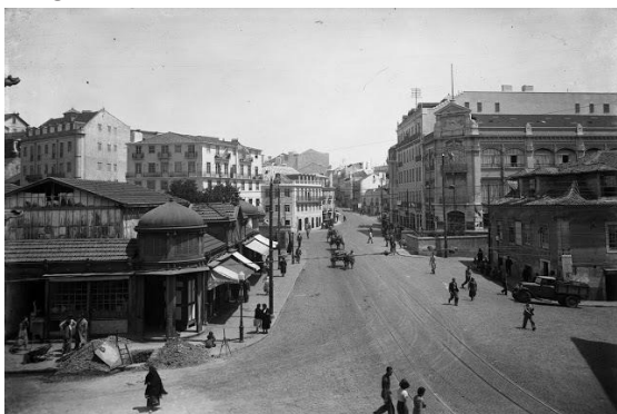
Figura 11. Local onde existiu a ponte de Alcântara na entrada da rua Prior do Crato, meado dos anos 40
