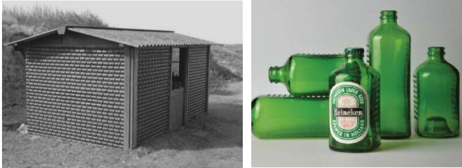
Figura 97 Building block of empty cans, sistema construtivo de Michael Reynolds para construção de paredes com latas de cerveja vazias da Thumb House (1973) (United States Patent Patente Nº 3,721,059, 1971) (Pinho, 2018).
