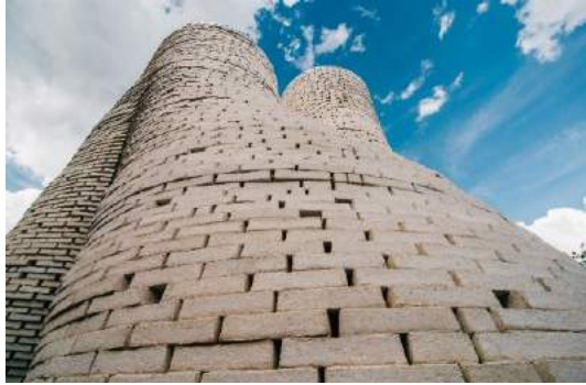
Figura 295 Construção do Hy-Fi ( The Creators Project, 2014)
