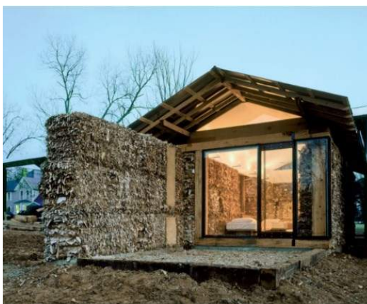
Figura 182 O Corrugated Cardboard Pod construído por estudantes do Estúdio Rural da Universidade de Auburn, AL, EUA. (Hebel, Wisniewska, & Heisel, 2014).
