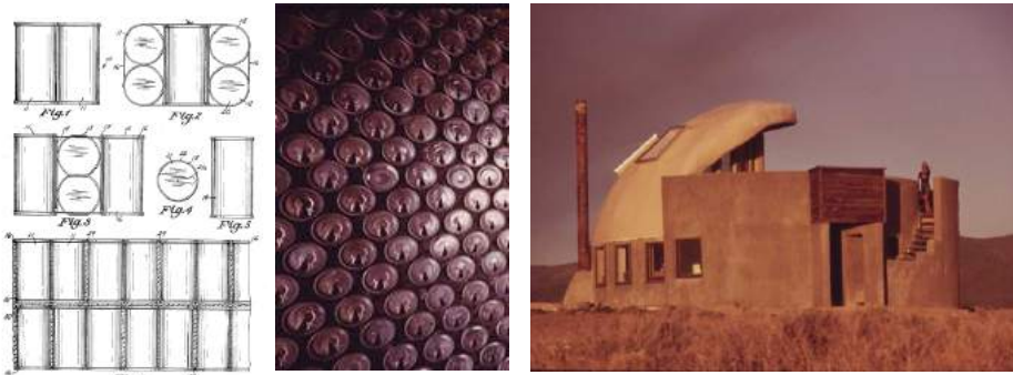
Figura 96 garrafa Heineken WOB0 projetada por John Harbraken em 1963, serviu para fazer paredes nas comunidades em desenvolvimento (Pinho, 2018).
