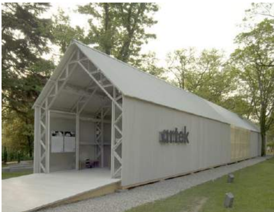
Figura 125 Fotografias do exterior do Artek Pavilion (Hebel, Wisniewska, & Heisel, 2014)
