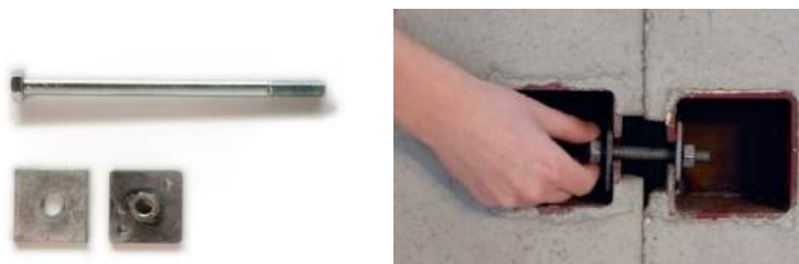
Figura 59 Exemplo de conexões entre os componentes com parafusos de transferência de carga acessíveis, colocados em caixas de ancoragem pré-moldadas incorporadas no componente. São Fáceis de apertar e desmontar. (Danish Environmental Protection Agency, 2019)
