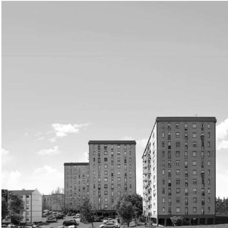
Figura 329 Complexo Habitacional da Quinta do Morgado Fotografia de Arqº. João Carmo Simões
