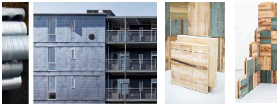
Figura 101 O primeiro protótipo é a fachada projeto Sømærk de Vandkunsten, foi construído com chapas metálicas de ductos de ventilação, através de um sistema slate cladding , sem comprometer e furar nenhum painel, permitindo a reutilização futura (Vandkunsten Architects, 2016)
