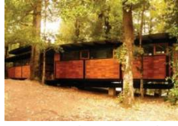
Figura 99 Casa de campo projetada em 1960 pelo arquiteto Juan Luis Martínez Nahuel no Chile, apresenta eucalipto e rauli reutilizados de locais próximos. (Gorgolewski, 2018).
