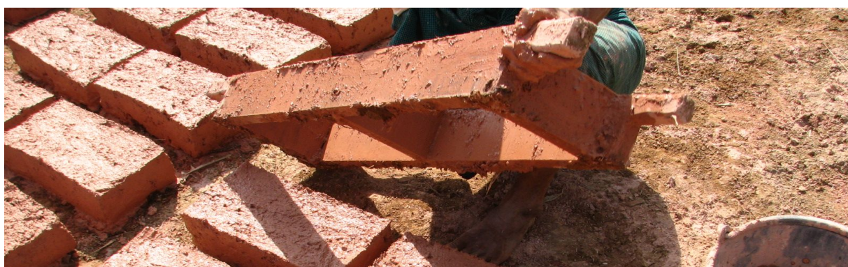
Figura 8- Desmoldagem de Blocos de Adobe (Fonte: https://pinterest.com/pin/431923420498305595/ )
