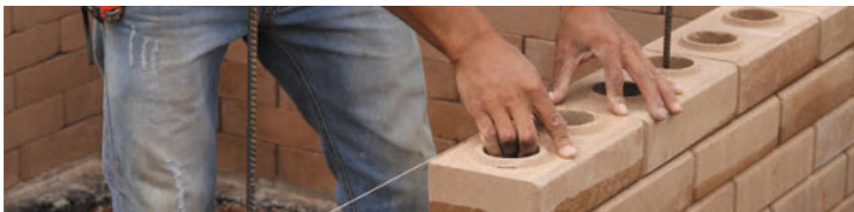
Figura 10- Construção Parede em BTC
