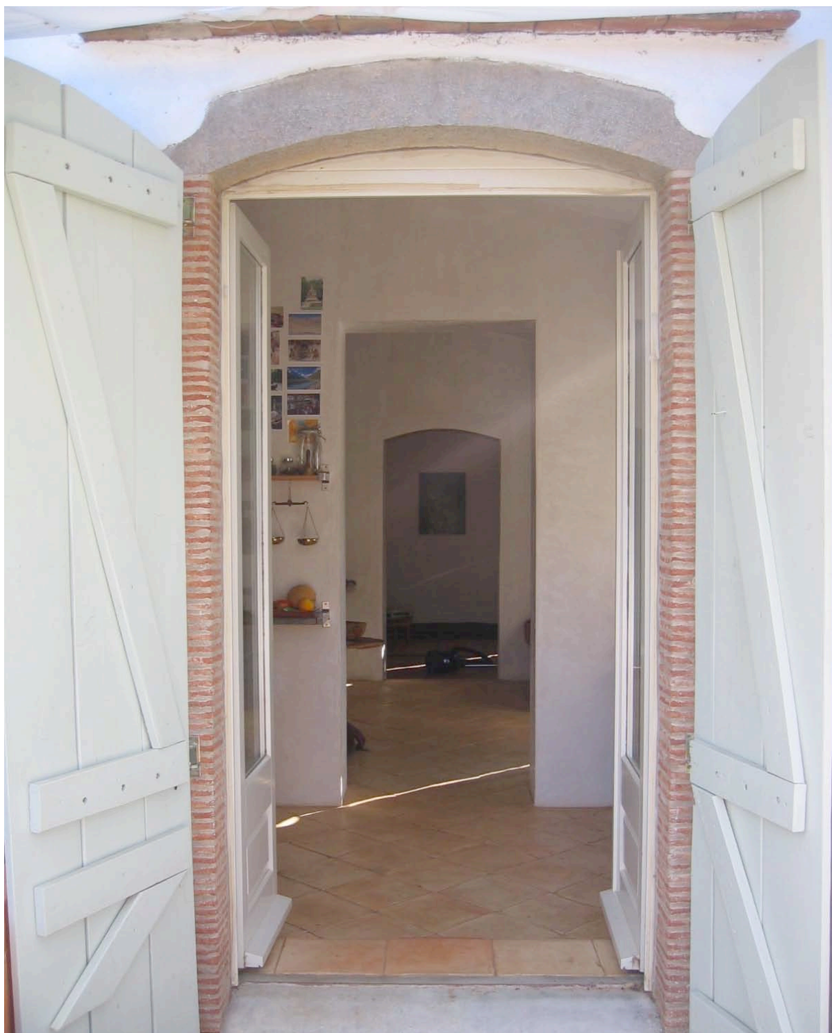
Figura 4.11: Resultado de uma das experiências construtivas. O interior: pavimento de ladrilhos de barro cozido, paredes de pedra originais reconstruídas e rebocadas com argamassa de cal, pintura de cal branca, arco de pedra, vão guarnecido e rematado com ladrilhos e argamassa de cal. (Fotografia de Fátima Barahona, 2009)
