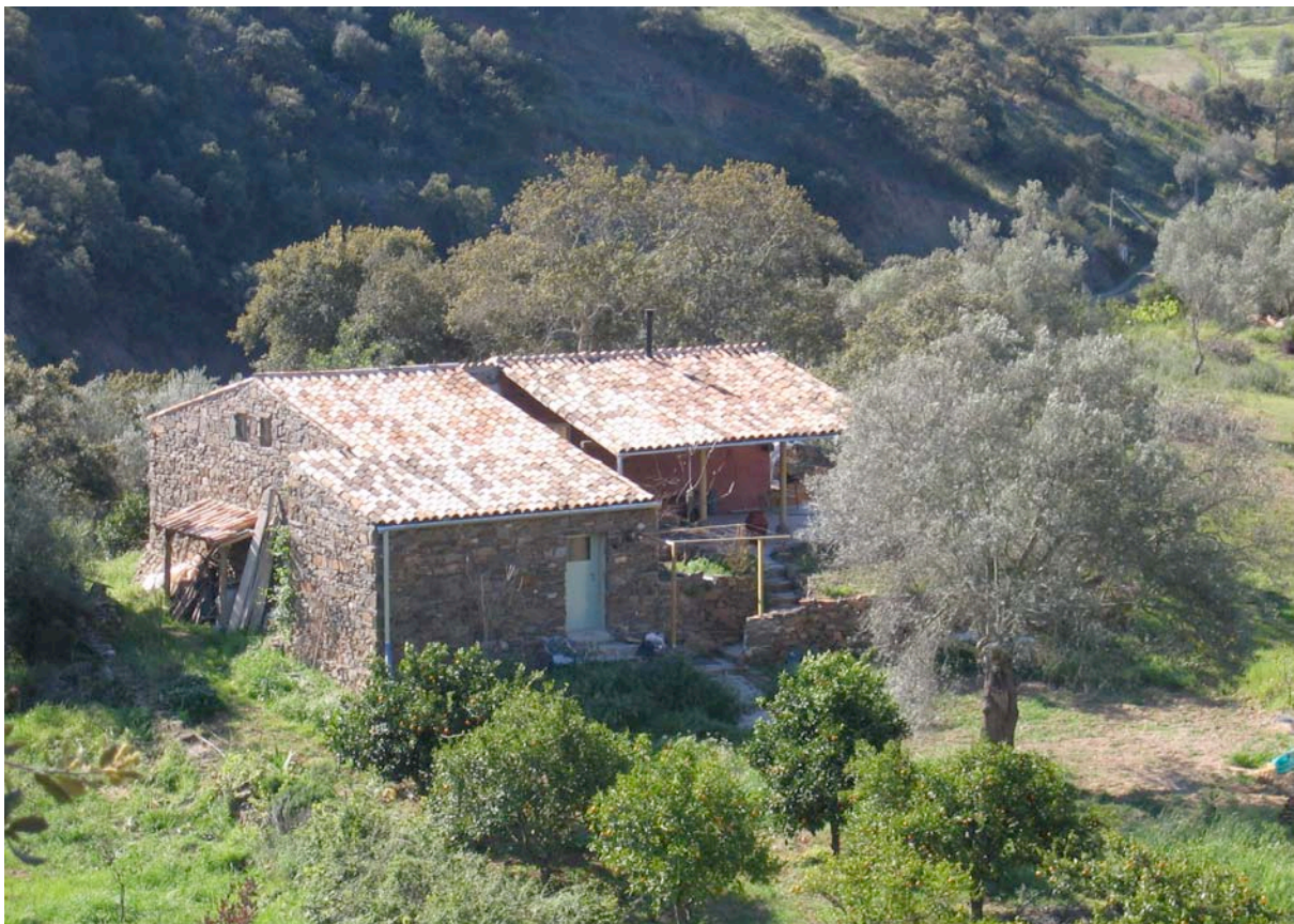
Figura 4.8: Fase de construção concluída. (Fotografia de Fátima Barahona, 2009)
