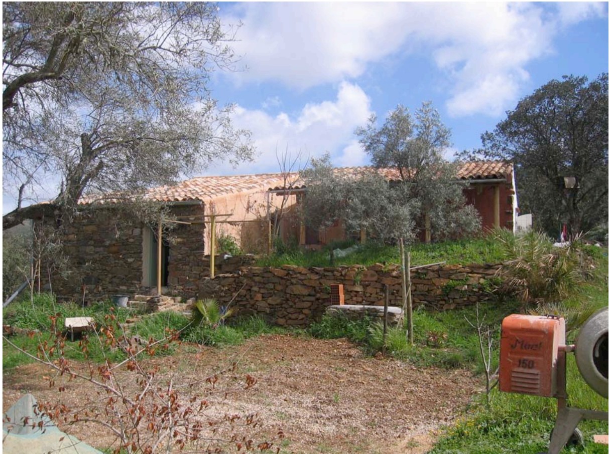
Figura 4.7: A casa em construção. (Fotografia de Fátima Barahona, 2006)
