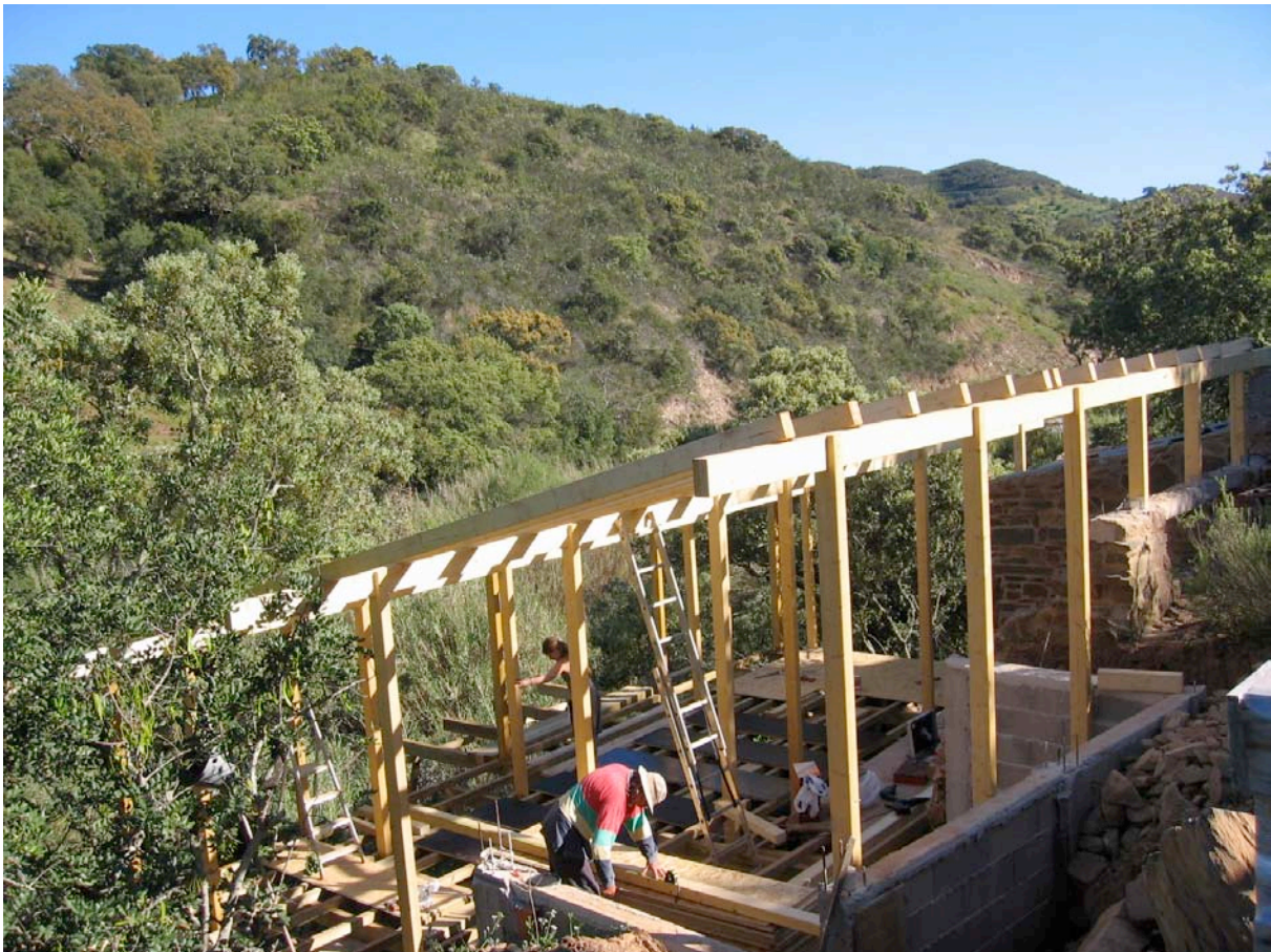
Figura 4.12: Durante a construção. (Fotografia de Fátima Barahona, 2010)
