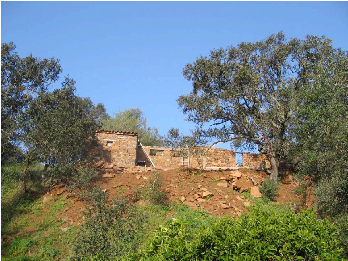
Figura 4.6: O primeiro abrigo em construção. Sítio de Morenos (Fotografia de Fátima Barahona, 2004)
