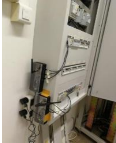
Figura 26: Instalação dos sensores no quadro elétrico
