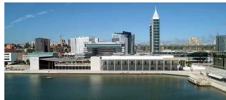
Figura 31 Pavilhão de Portugal - Expo 98
