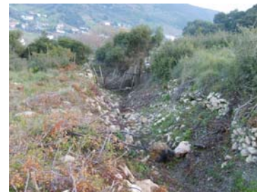
Figura 56 - Estrada militar situado numa zona de propriedade privada, onde o proprietário colocou uma vedação de rede ovelheira impedindo a continuidade do percurso, obrigando a efectuar-se um pequeno desvio. Situação que deverá ser rectificadas de forma a garantir a continuidade deste corredor verde. (CONDE, C., 2007)
