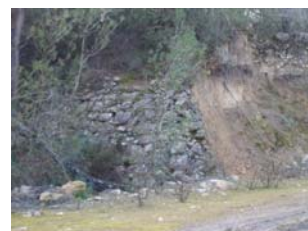
Figura 42- Exemplo da destruição do forte 115, em consequência da abertura de um caminho de acesso à zona de extracção de inertes. (CONDE, C. 2007)
