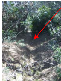
Figura 59 – Estruturas existentes que poderão constituir o sistema de drenagem das primeiras fortificações (CONDE, C., 2009)
