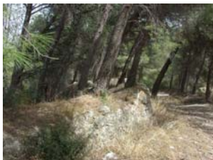
Figura 67- Existência de árvores sobre as paredes do forte 114 b) (CONDE, C., 2007)
