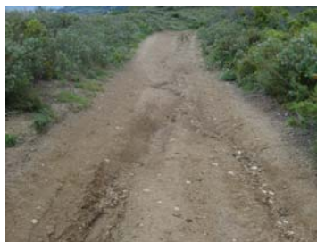
Figura 55 – Caminho rural que evidencia sinais de erosão, tornando-o irregular, dificultando a sua utilização (CONDE, C., 2007)
