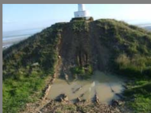
Figura 45 – Exemplo dos danos causados pela prática de motocrosse no forte n.º 42 (Serra da Agueira (CONDE, C. 2008).
